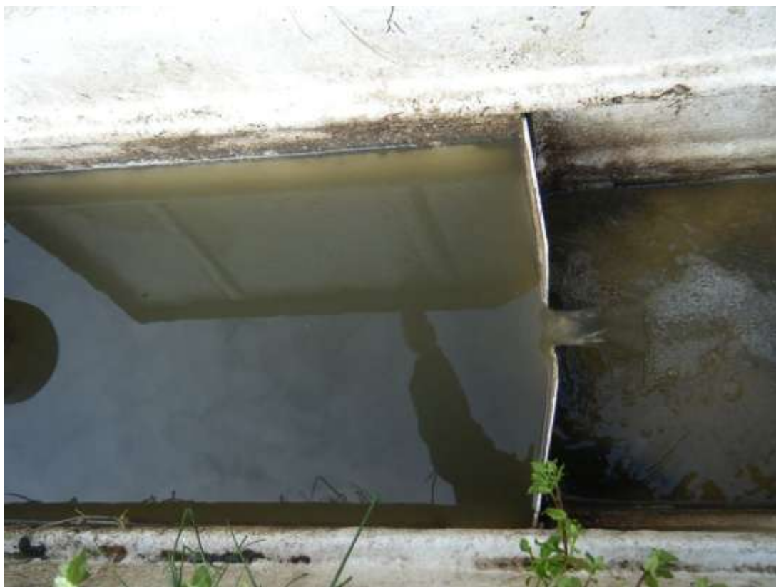
Photo N°8 : Canal de comptage de l'effluent traité.
