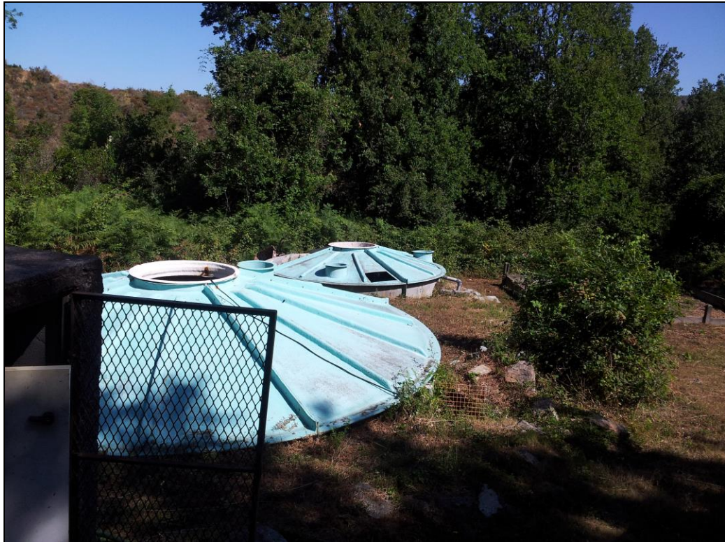
Photo 2 : Aperçu de la station Ouest (du stade)
