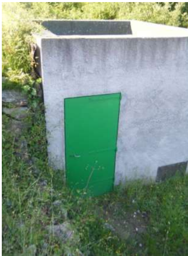
Photo N°2 : Porte du local technique du PR réparée et peinte.
