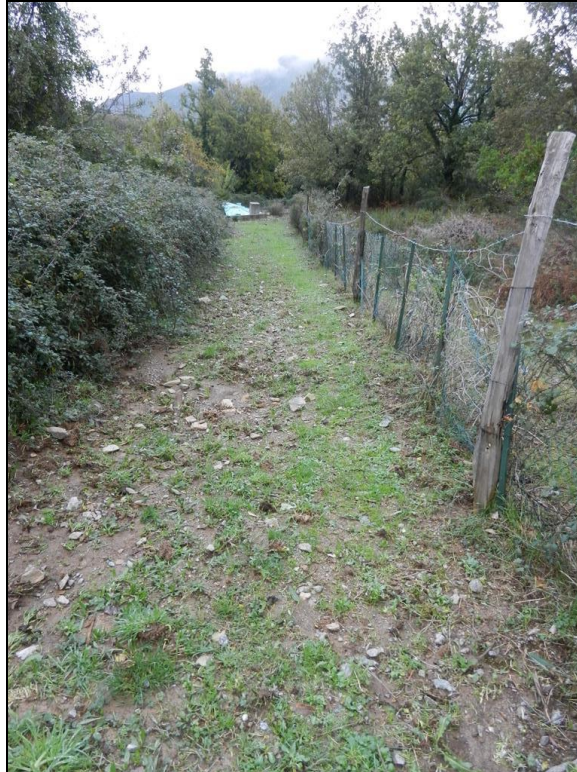
Photo 3 : Chemin d'accès vers la station du stade
