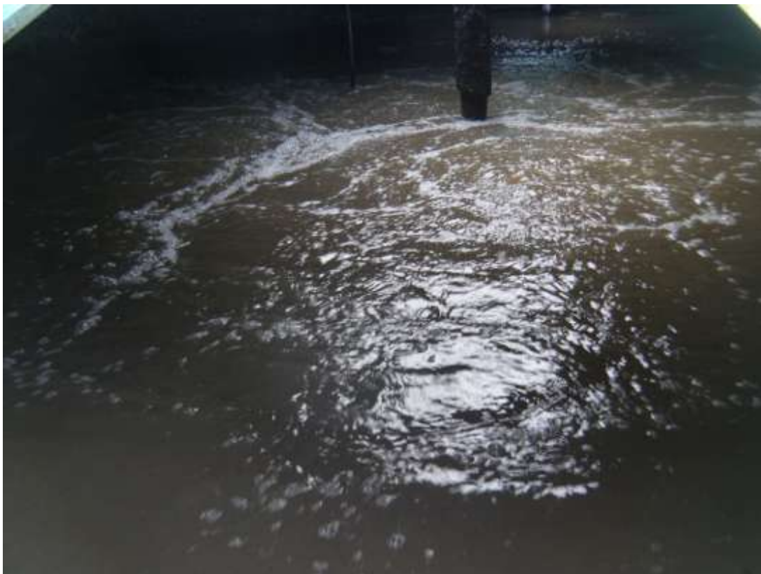
Photo N°2 : Bullage dans le bassin d'aération. Les boues sont peu concentrées à l'intérieur du bassin.
