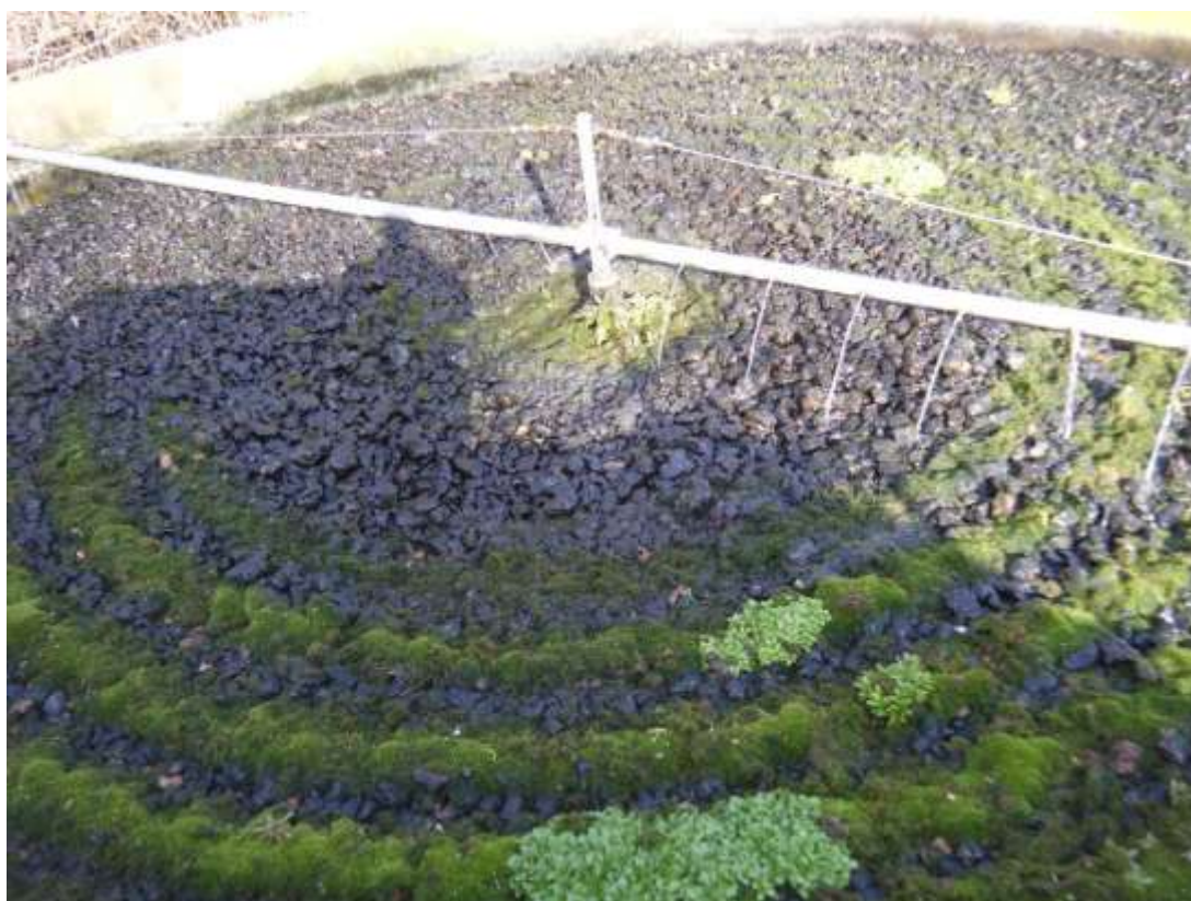
Photo N°4 : Mousses et végétation à enlever à la main.
