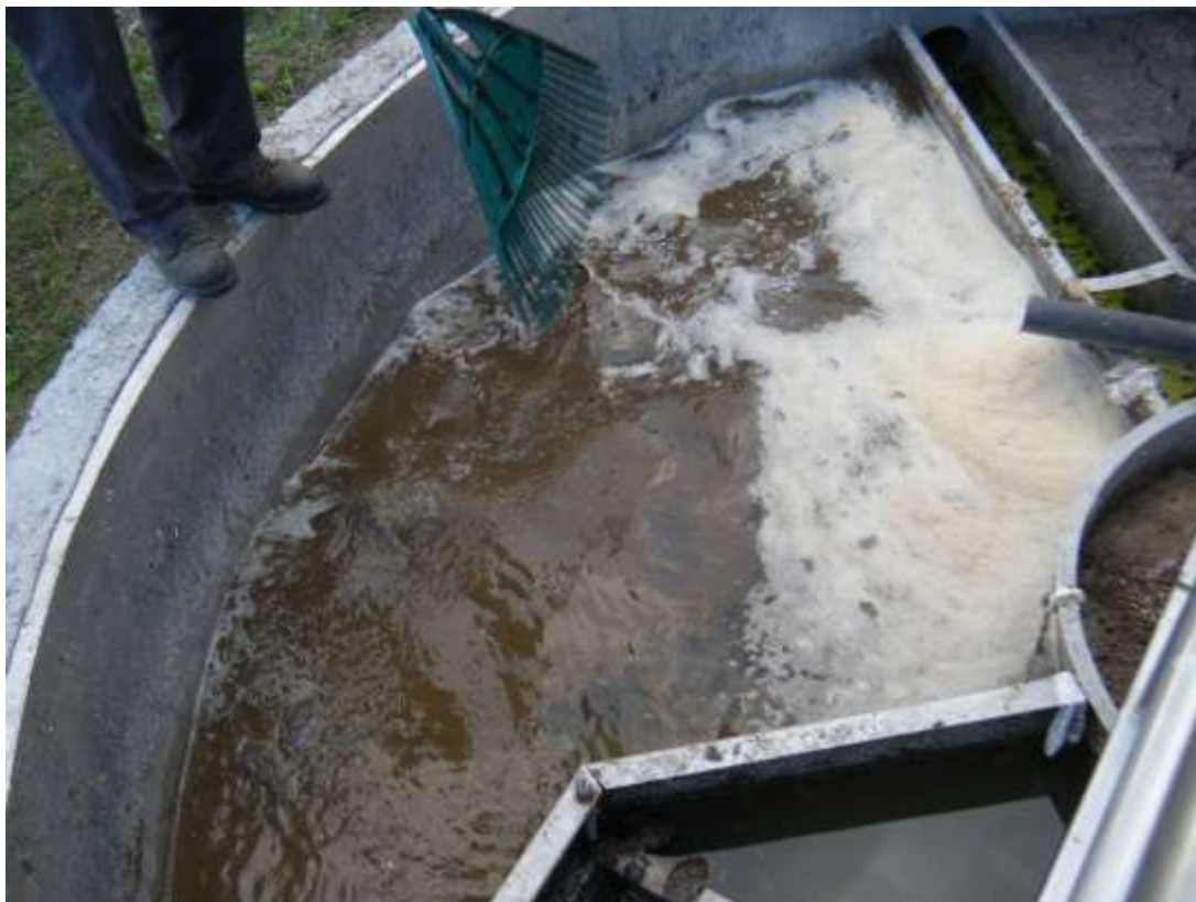
Photo N°7 : Coulage des boues sur un des côtés du décanteur digesteur.
