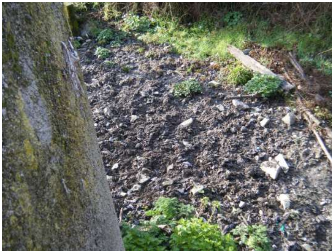
Photo N°2 : La majorité des déchets présents au pied du décanteur digesteur a été évacuée. Ratisser les quelques déchets encore présents et les évacuer à la décharge ou les brûler sur place.
