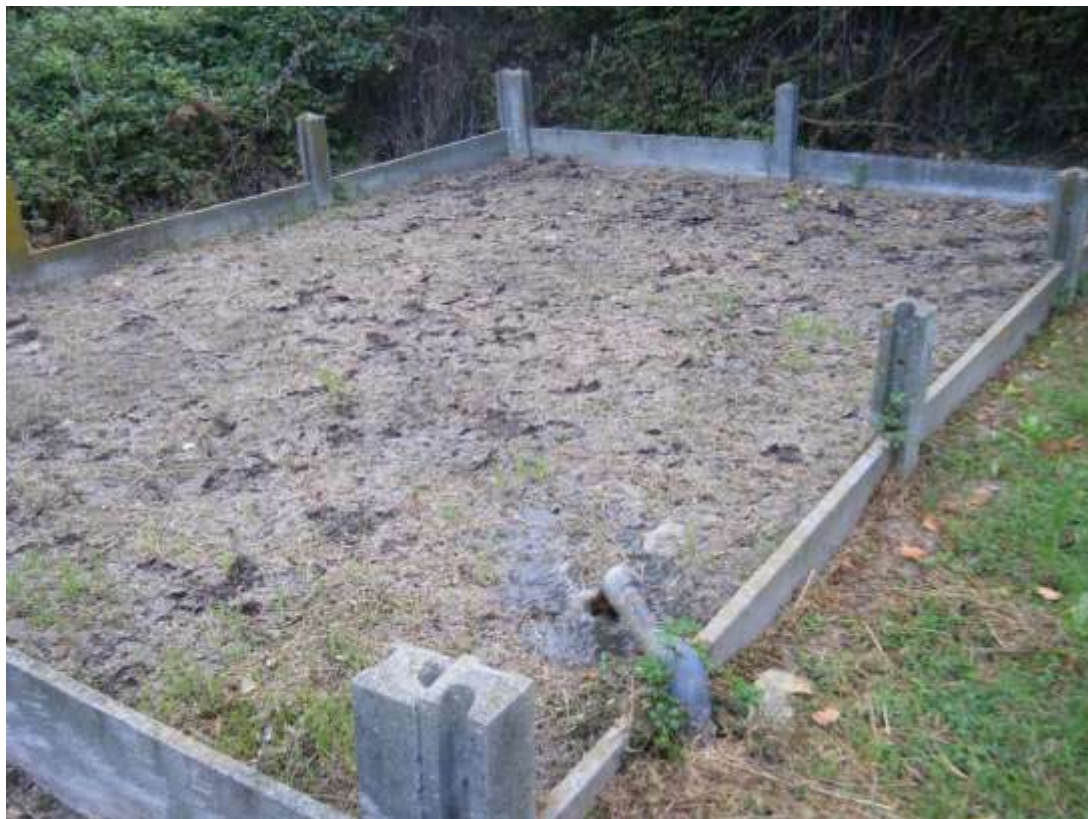
Photo N°9 : Soutirage de boues sur un lit où les anciennes boues n'ont pas été préalablement évacuées au pied du lit dans l'attente d'être envoyées vers un centre agréé.
