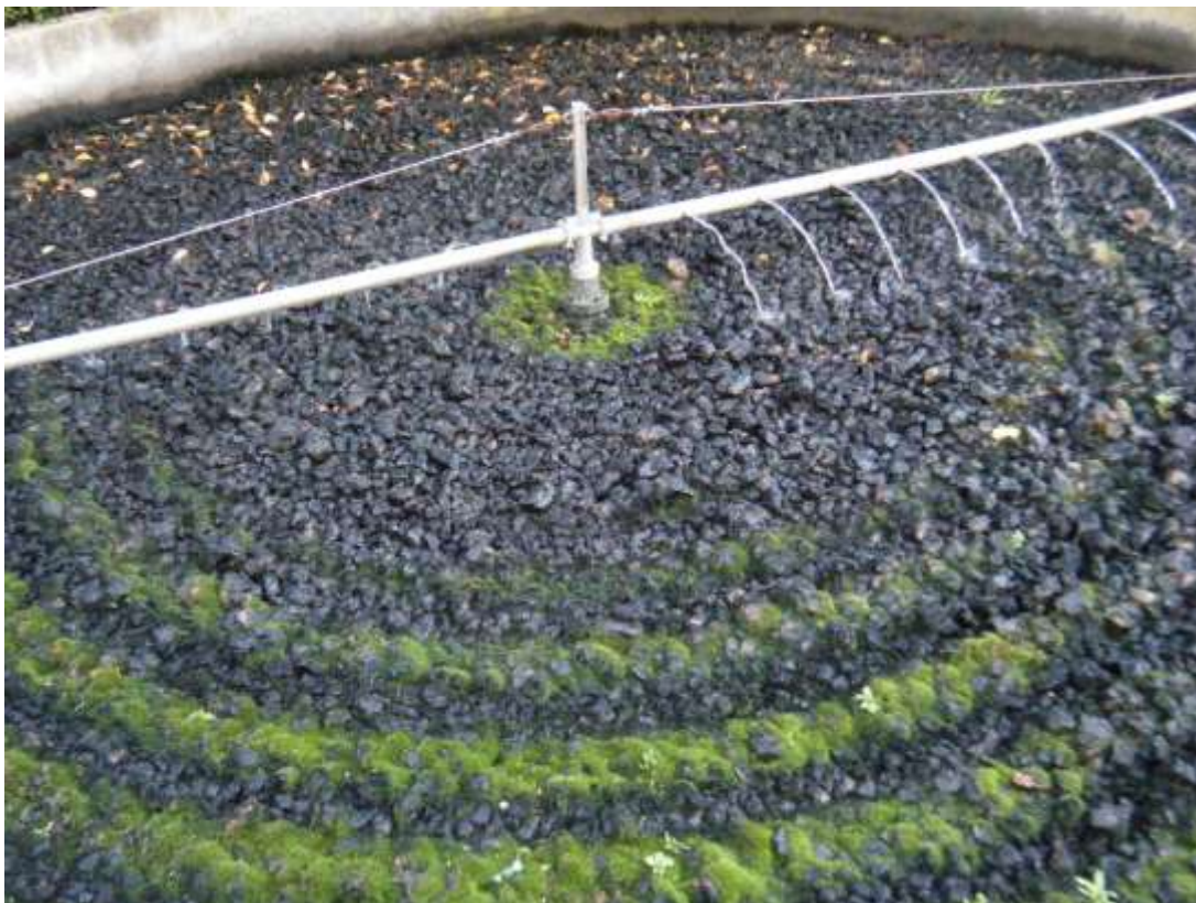
Photo N°10 : Pouzzolane du lit bactérienensemencée.
