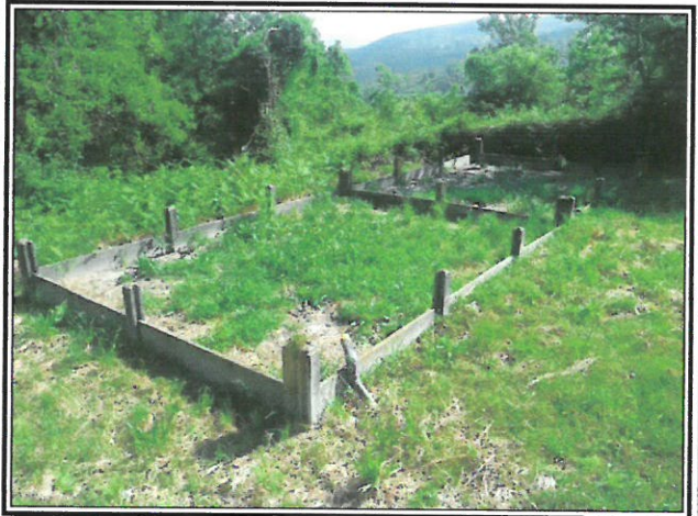
Illustration 4: Vue des lits de séchage. Il n'existe aucune filière de valorisation des boues d'épuration.
