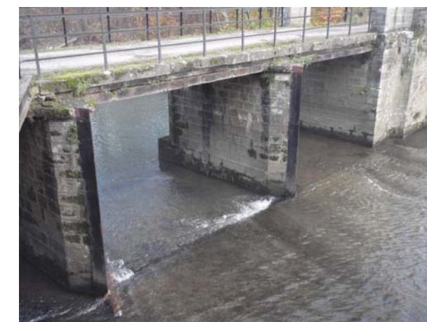
Photos n° 5 et 6 : Radier bétonné de l'ouvrage et pont d'accès au site
