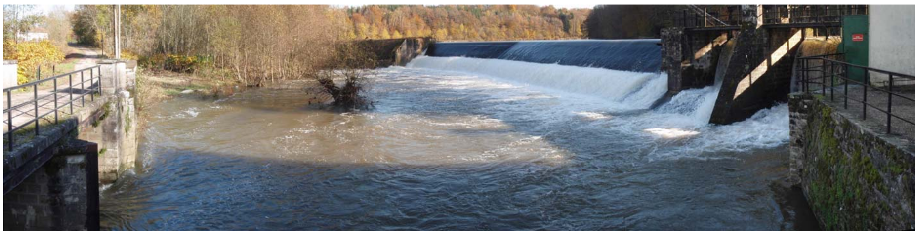
Photo n° 2 : Barrage du Gros Moulin et vannage de décharge
