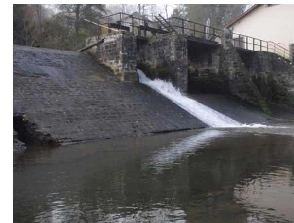
Photo n° 3 : Ecoulement du débit réservé actuel
