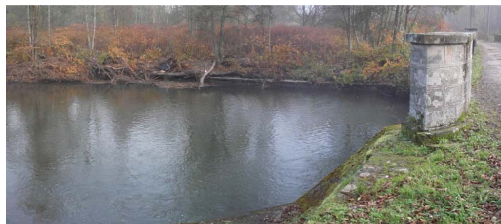
Photo n° 7 : Profil profond en aval du pont d'accès
