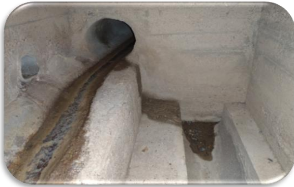
Photo du déversoir 1 Amont
