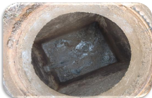
Photo du déversoir 3 Aval
