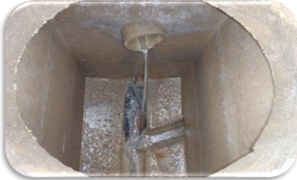
Photo du déversoir1 Aval
