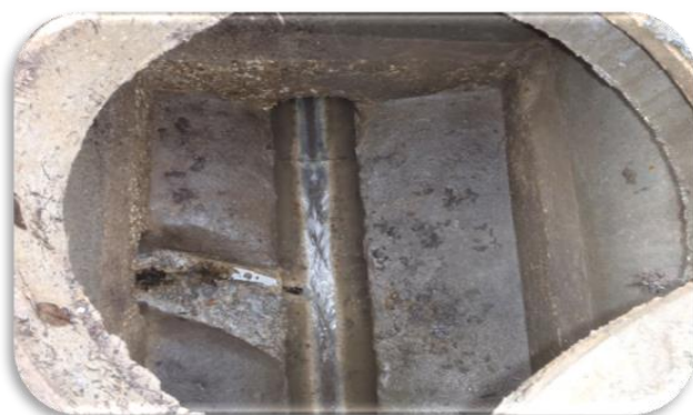
Photo du déversoir 2 Aval
