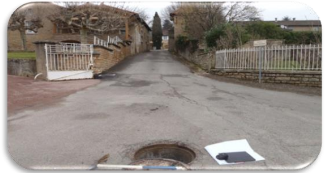
Localisation du D01 Amont
