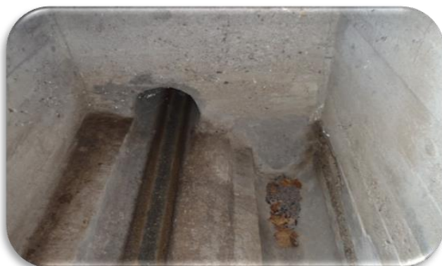
Photo du déversoir2 Amont
