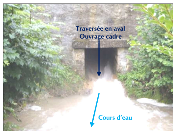
Traversée du Nant d'Iné sous la RD 20
