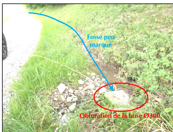
Amont du fossé du chemin rural du Ravin
