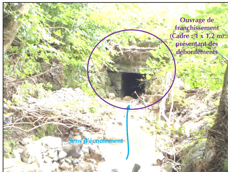
Ouvrage de franchissement (cadre 1 x 1,2 m)
