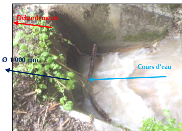
Traversée du Nant d'Iné sous la RD 20
