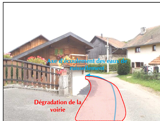
En aval du chemin du Bois de Sot
