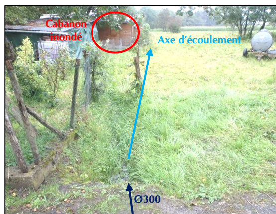
Aval de la buse Ø300 - Ruisseau de la Fléchère
