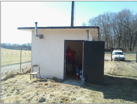
Local du forage
