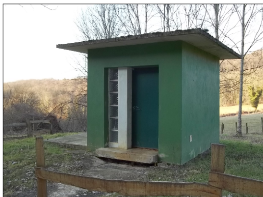
Local de traitement
