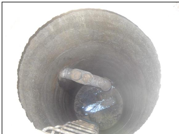
Photo 11 : traces d'infiltrations visibles sous le rejet du branchement privé (REIG. 0076)
