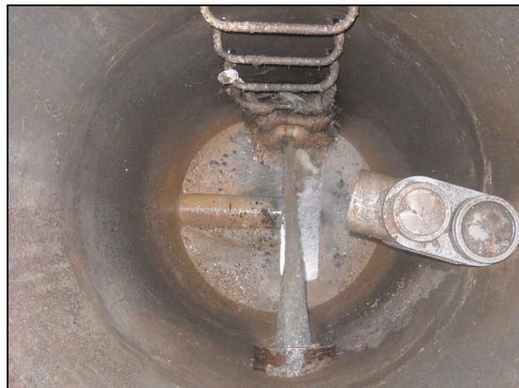
**Photo 7 : obstacle à l'écoulement (échelon) entraînant la formation de dépôts (PERS. 0235)**
