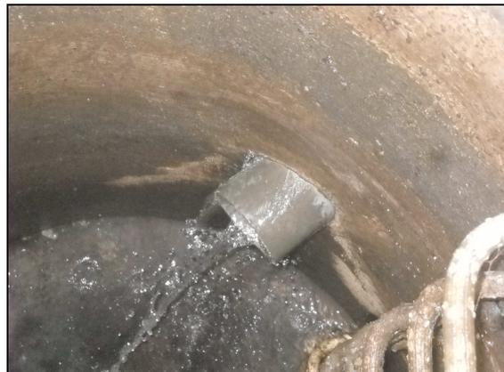
**Photo 2 : branchement mal renformi sujet à des infiltrations d'eaux claires + écoulement régulier d'eaux claires en provenance du branchement (REIG 0117)**
