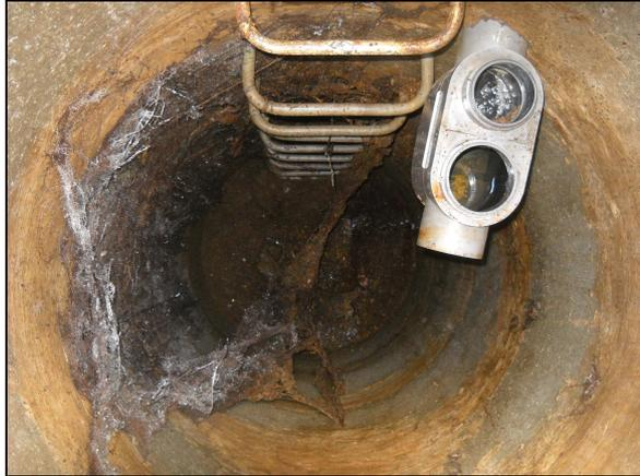
**Photo 4 : importante introduction de racines avec obstruction partielle du réseau entraînant un risque de colmatage (SCIE 0103)**
