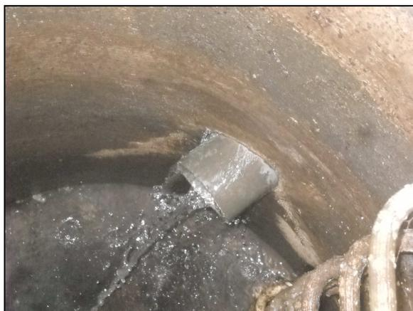
Photo 13 : branchement mal renformi sujet à des infiltrations d'eaux claires + écoulement régulier d'eaux claires en provenance du branchement (REIG 0117)
