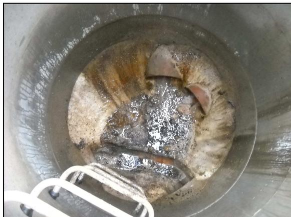
Photo 10 : concrétions calcaires sur banquettes et suintements d'eaux claires sur paroi (AREN. 0098)
