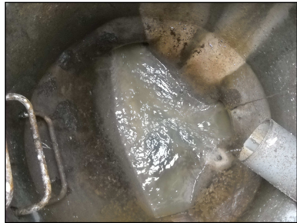
Photo 14 : suintements d'eaux claires sur paroi (FILL. 0050)
