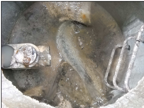
Photo 13 : concrétions calcaires (MARC. 0169)
