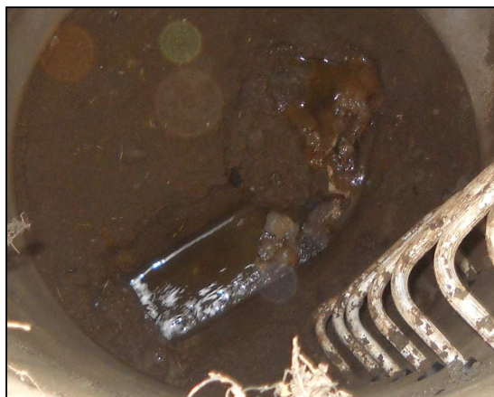
Photo 8 : amas de dépôts – risque de colmatage (CONT. 0436)
