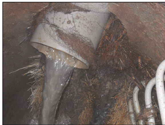
Photo 5 : branchement particulier mal renformi introduction de racines (CONT. 0403)
