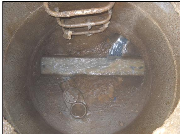
Photo 12 : traces de mises en charge sur les deux échelons inférieurs (FILL 0618)
