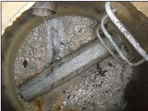
Photo 11 : dépôts de graisses sur banquettes en provenance de l'antenne (FILL 0227)
