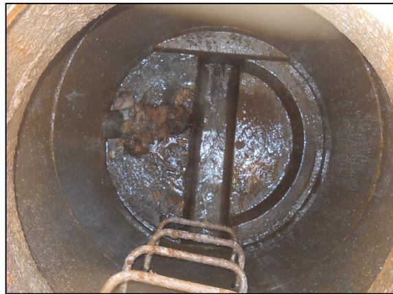
Photo 14 : fortes intrusions d'eaux claires - joints couronnes inférieures non étanches (FILL 0555)
