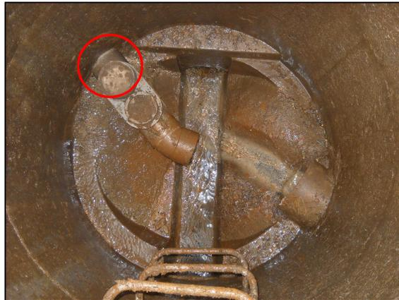
**Photo 3 : branchement mal renformi avec infiltrations d'eaux claires parasites (FILL 0054)**
