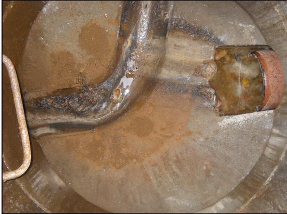
Photo 9 : obstacle à l'écoulement – rejet antenne mal réalisé entraînant la formation de dépôts (FILL 0414)
