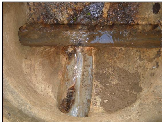
Photo 15 : pissettes d'eaux claires localisées sur la cunette de l'antenne (FILL 1140)
