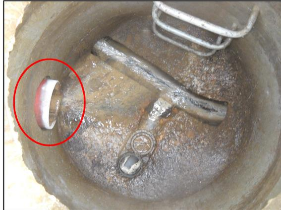
**Photo 4 : raccordement antenne mal renformi
