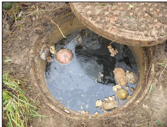
Photo 16 : regard eaux pluviales en charge
