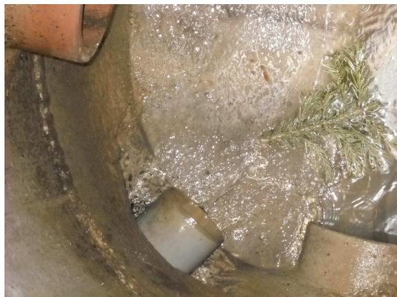
Photo 7 : branchement particulier mal renformi avec infiltration d'eaux claires
