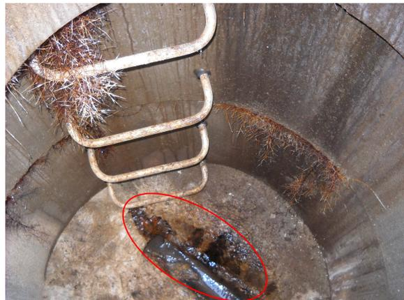
Photo 18 : écoulements d'eaux claires sur banquette et introduction de racines
