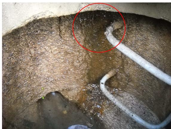
Photo 20 : infiltration des eaux de ruissellement de surface
