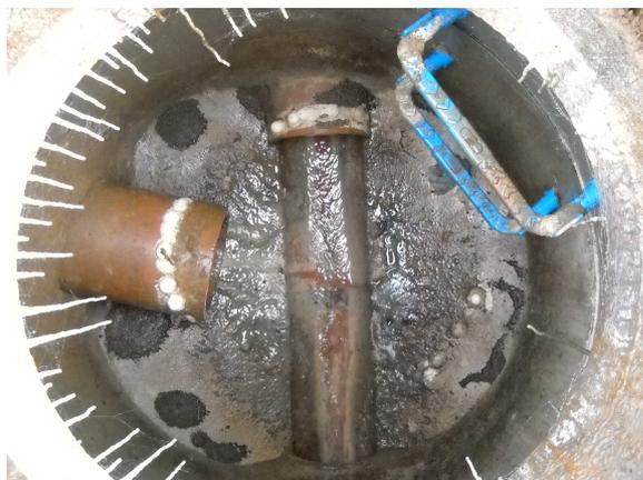
**Photo 15 : concrétions calcaires**
