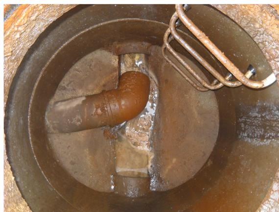
**Photo 11 : obstacle à l'écoulement (coude antenne) entraînant la formation de dépôts**
