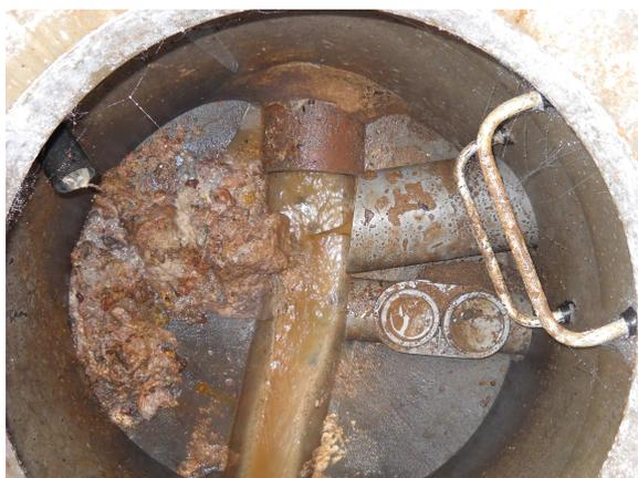
**Photo 10 : dépôts sur banquettes**
