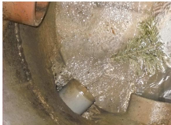
**Photo 2 : branchement mal renformi avec infiltration d'eaux claires**
