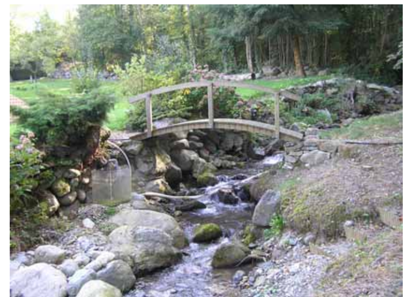
Passerelle bois (ouvrage n°6) et captage sauvage (photo dmonin/onf)
