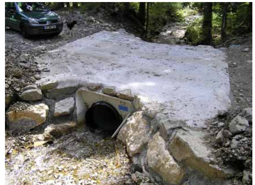
Ouvrage n°7 : passage busé avec radier bétonné (photo dmonin/onf)
