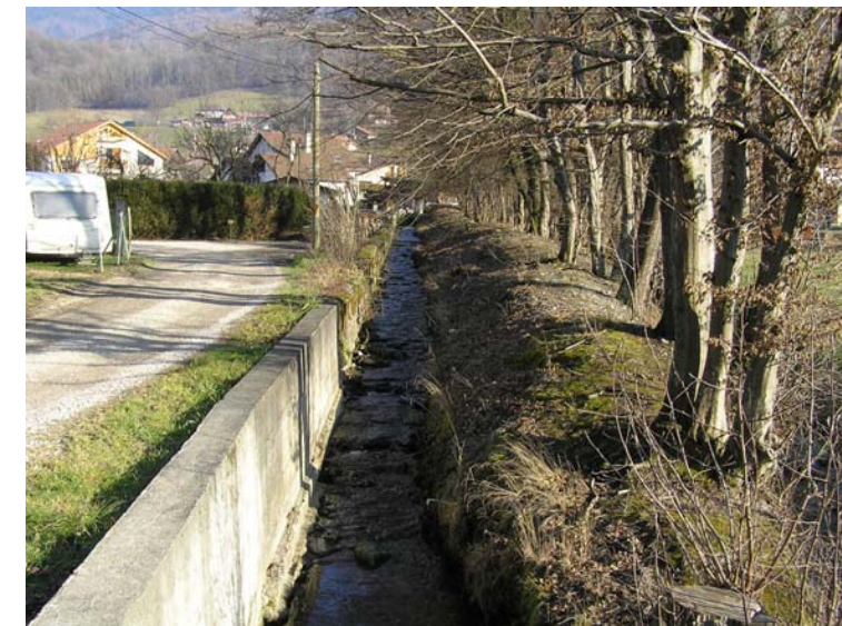
Le ruisseau du Vernon canalisé et bordé par un mur de soutènement Photo d.monin/onf
