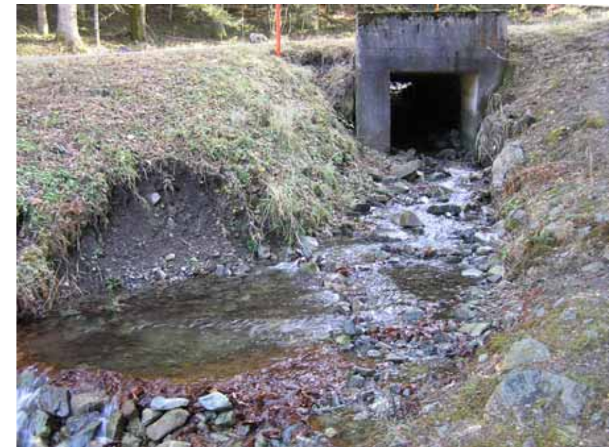
Ouvrage n° 6, sous la RD 111 (photo dmonin/onf)
