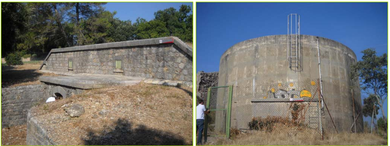
Figure 4 : Les deux réservoirs du village (Les Aires et Chapelle)
