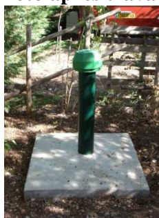
Photo après travaux
