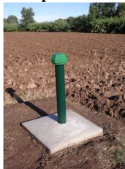
Photo après travaux
