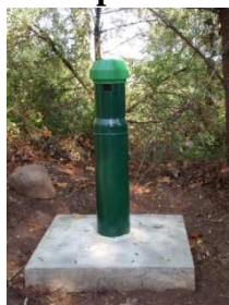
Photo après travaux
