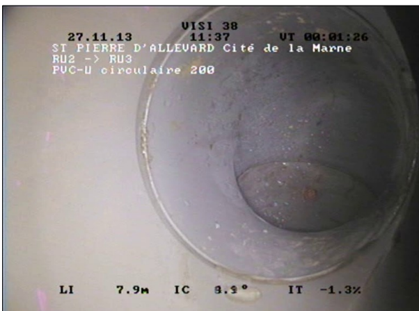
Photo: 0000011.JPG 7,91m, Culotte, raccordement ouvert à 1 h., -, (-)
