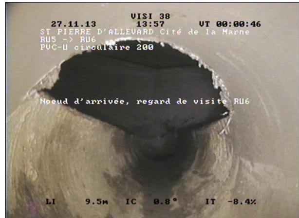
Photo: 0000037.JPG 10,26m, Noeud d'arrivée, regard de visite RU6
