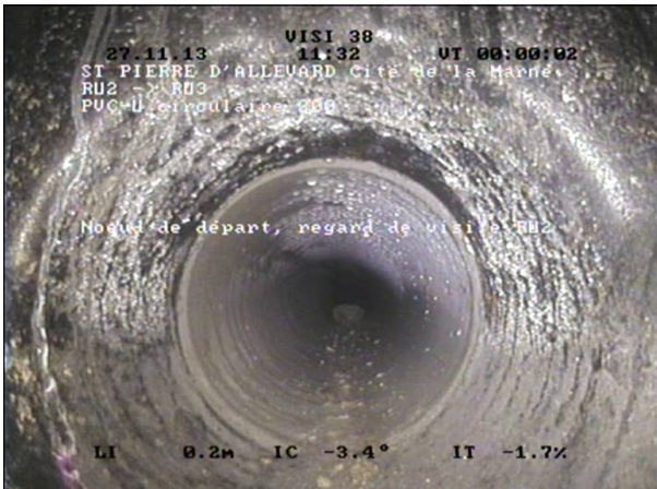
Photo: 0000009.JPG 0m, Noeud de départ, regard de visite RU2
