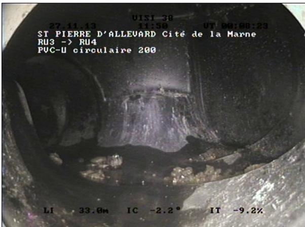
Photo: 0000031.JPG 33,43m, Noeud d'arrivée, regard de visite RU4
