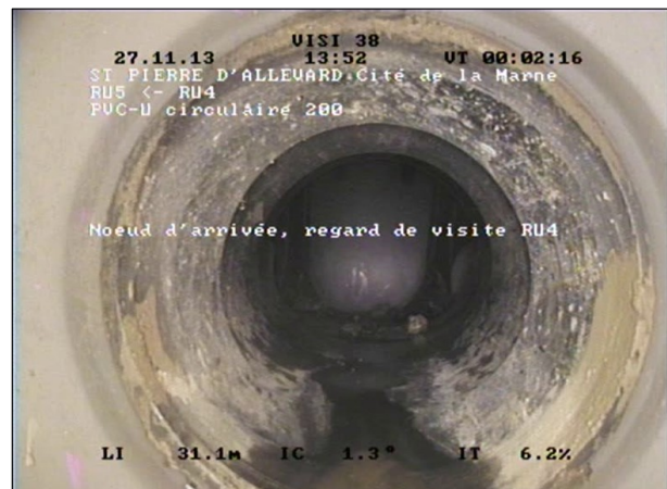
Photo: 0000035.JPG 32m, Noeud d'arrivée, regard de visite RU4
