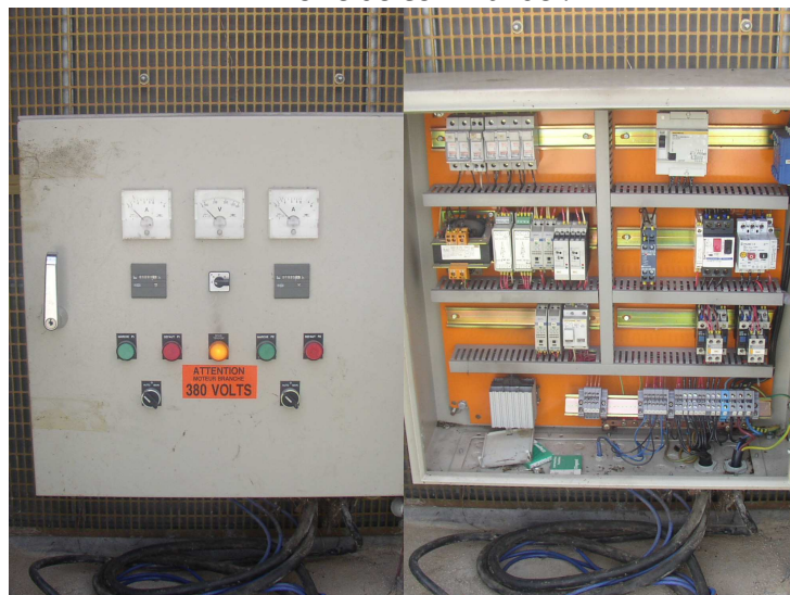
Armoire de commande :
