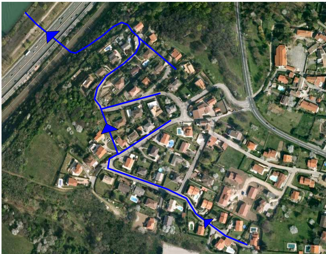
Figure 3-7 : Vue aérienne des axes principaux de ruissellement du bassin de collecte du secteur les Sauvages
