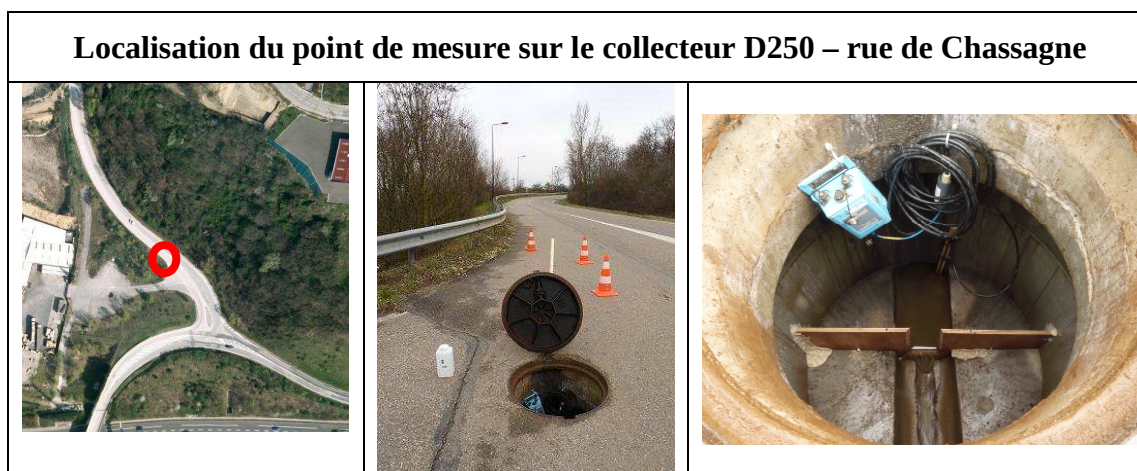
Figure 2-2 : Point de mesure sur le Ø250 – rue de Chassagne
