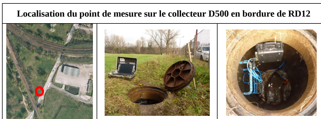
Figure 2-1 : Point de mesure sur le Ø500 – sous la RD12
