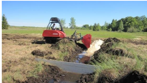
Figure 27 : Comblement d'un fossé de drainage en zone humide, source : photo CC Frasne-Drueon.
