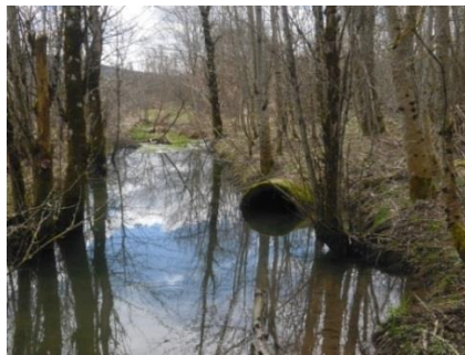
Figure 15 : Photographie du rejet des eaux usées d'Aranc dans le fossé ouest, source : C. Thuiller, avril 2013.
