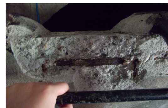
Armature apparente sur le haut du réservoir
