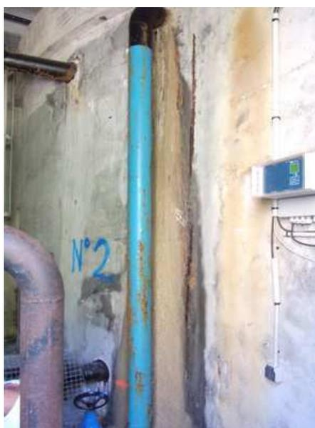
Figure 7 : Injection de chlore au niveau du réservoir du Seuil
