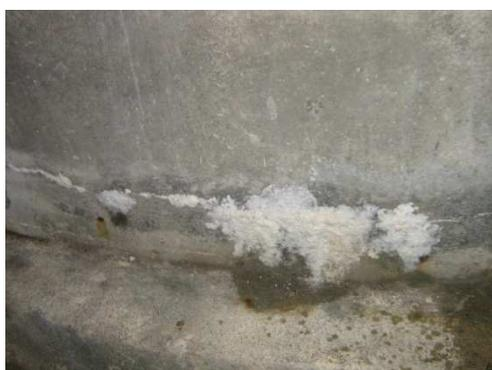
Traces de calcite sur le bas du voile extérieur du réservoir
