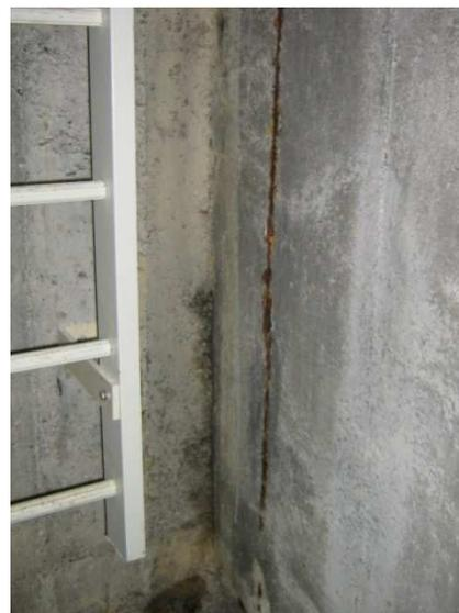
Fissure sur le voile extérieur du réservoir
