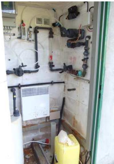
Figure 4 : Injection de chlore au niveau du Plan de Puget
