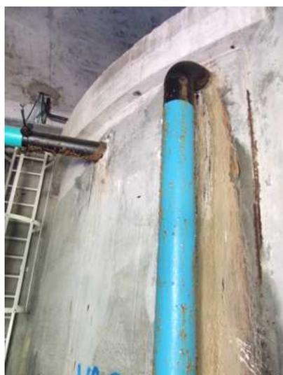
Défaut d'étanchéité sur la canalisation de surverse
