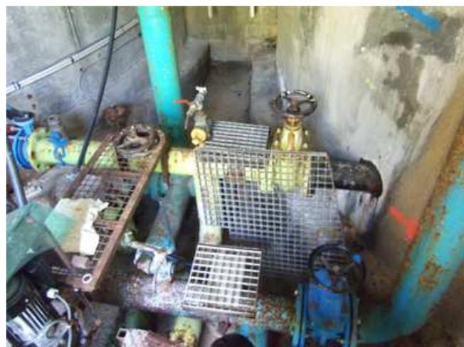
Equipements hydrauliques corrodés
