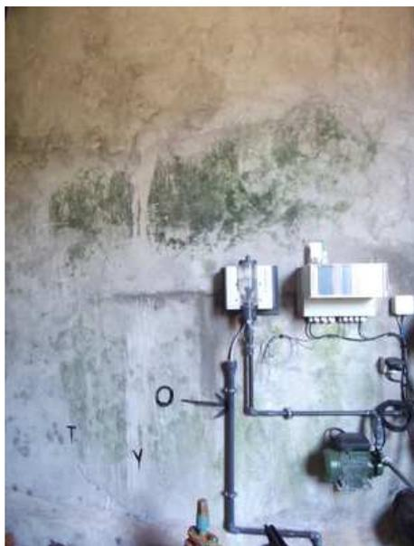
Figure 6 : Injection de chlore au niveau du réservoir de la Tour
