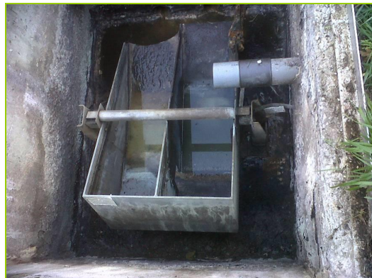
Figure 74 : La chasse à auget basculante
