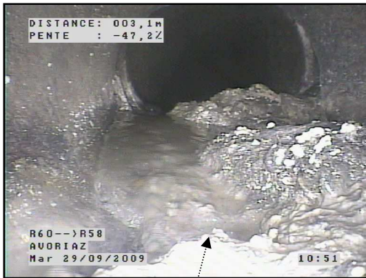
R.60 à R.58 : Dépôts durs et compacts
