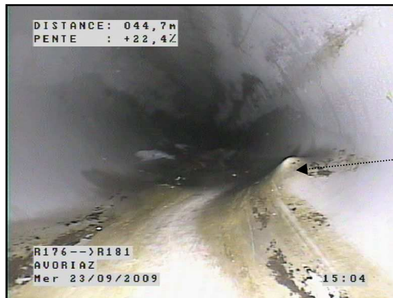
R.185 à R.182 : Changement de section / sol visible / exfiltration
