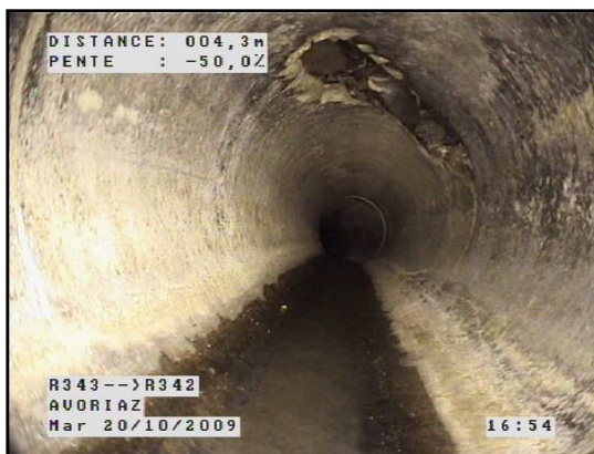
R.343 à R.335 : Plusieurs gros trous dans la voute supérieure avec infiltration d'eaux parasite
