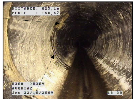
Trace d'infiltration
