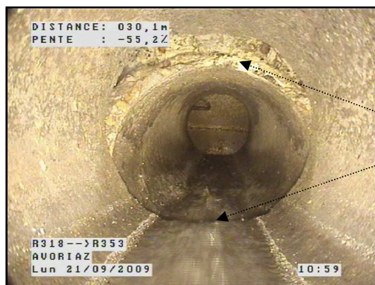
R.315 à R.316 : Infiltration et Exfiltration par fissure circonférentielle
