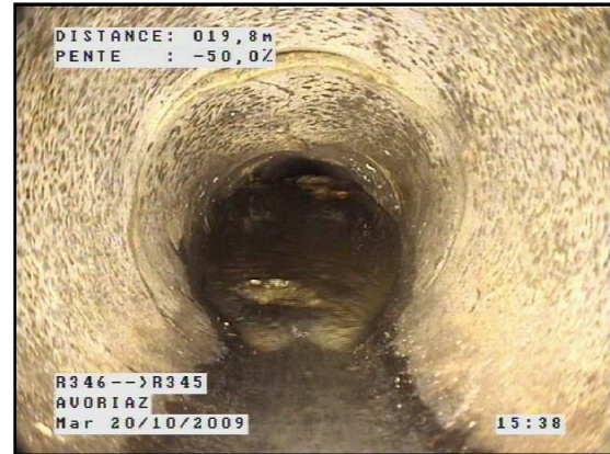
R.346 à R.345 : Bouchon du aux casses du réseau. Vue amont et aval.
