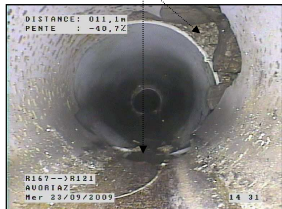
R.167 à R.121 : Tuyau PVC Cassé / sol visible / exfiltration
