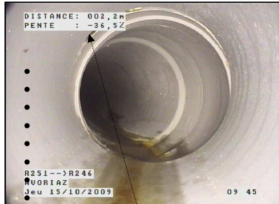
R.251 à R.246 : Déboisement / infiltration / Exfiltration
