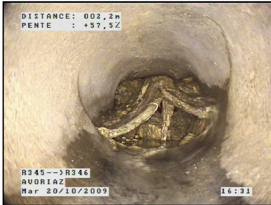
R.346 à R.345 : Bouchon du aux casses du réseau. Vue amont et aval.
