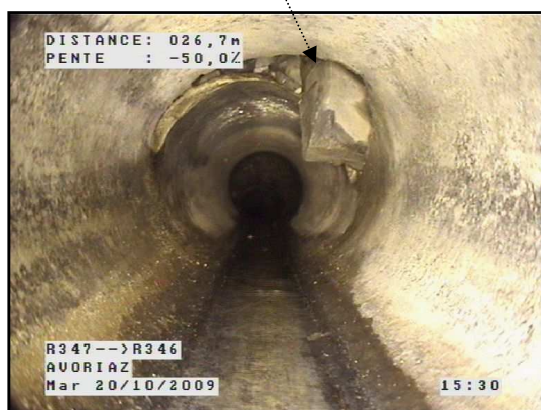
R.347 à R.346 : Casse de la voute supérieure, entrée de blocs, infiltration
