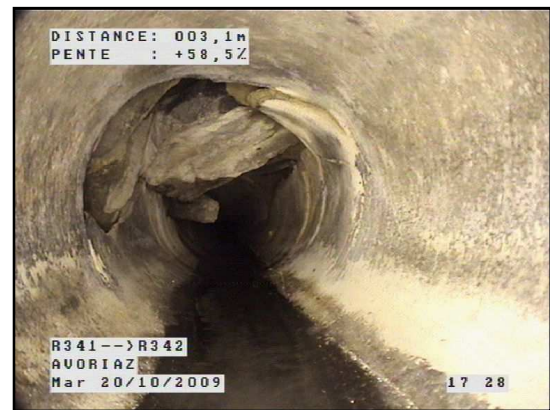
R.342 à R.335 : Plusieurs grosses casses sur ce tronçon avec infiltration d'eau parasites
