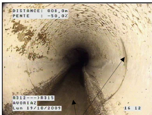
R.315 à R.316 : Infiltration et Exfiltration par fissure circonférentielle
