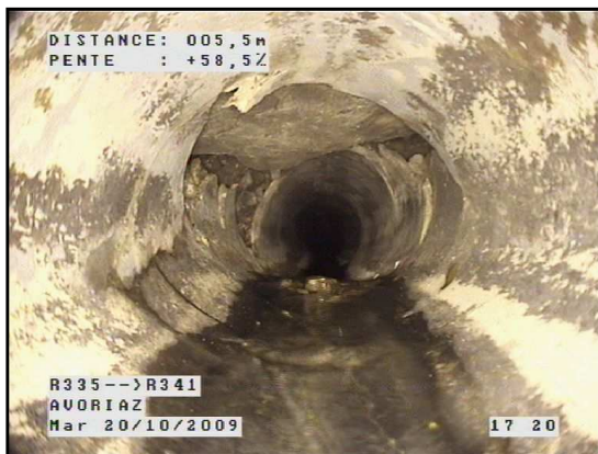
R.342 à R.335 : Plusieurs grosses casses sur ce tronçon avec infiltration d'eau parasites
