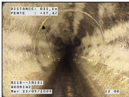
R.121 à R.118 : Fissure circonférentielle ouverte
