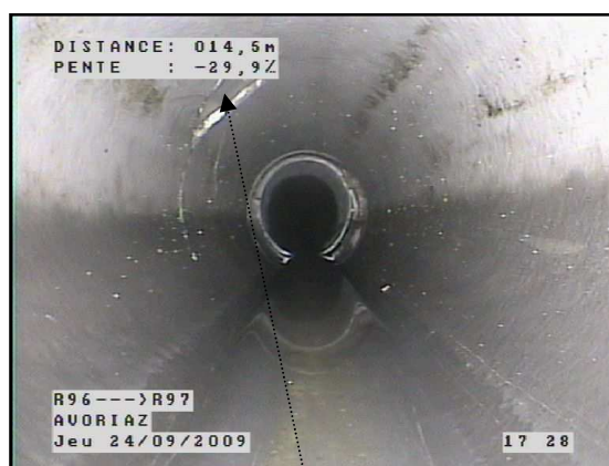
R.96 à R.97 : Trou dans la paroi supérieure réparé
