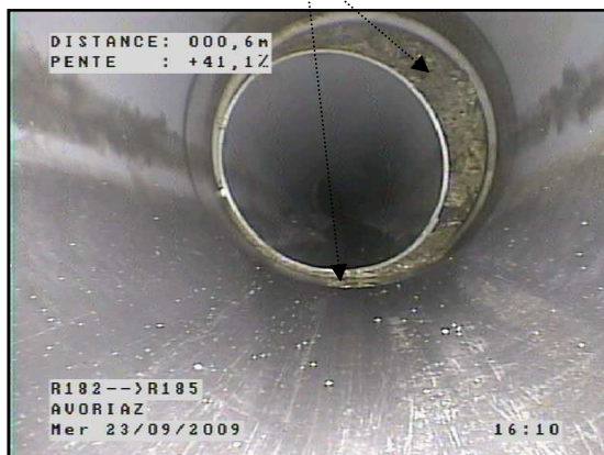
R.185 à R.182 : Changement de section / sol visible / exfiltration
