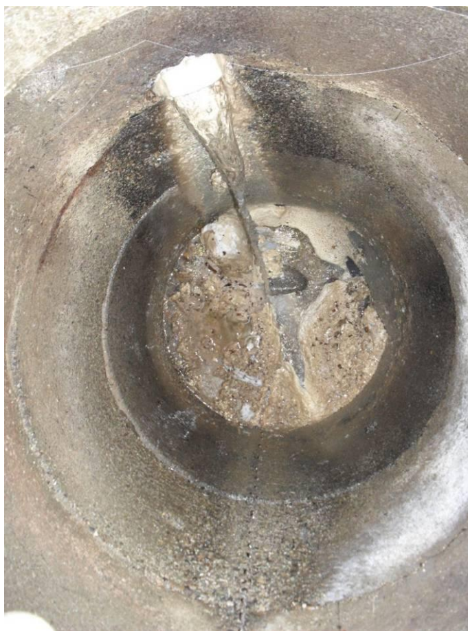
Photo : Présence de graisse - RV 2927-Entrée Hôtel de ville
