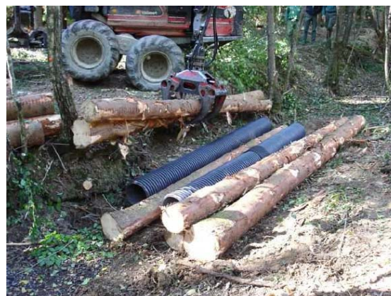
Mise en place d'un kit de franchissement (Photo ONF)
