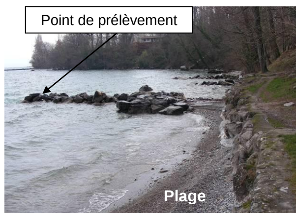
Figure 44 : Localisation du point de prélèvement au droit de la digue
