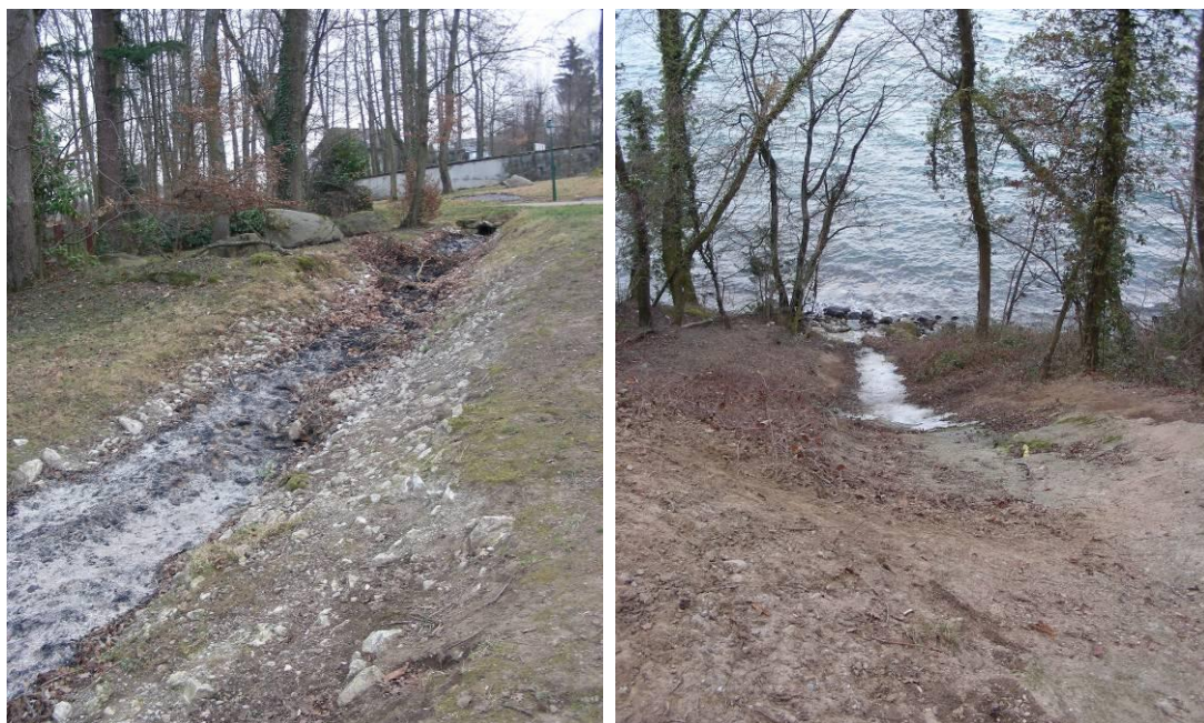
Figure 35 : Rejet d'eaux pluviales se jetant à l'est de la zone de baignade.
