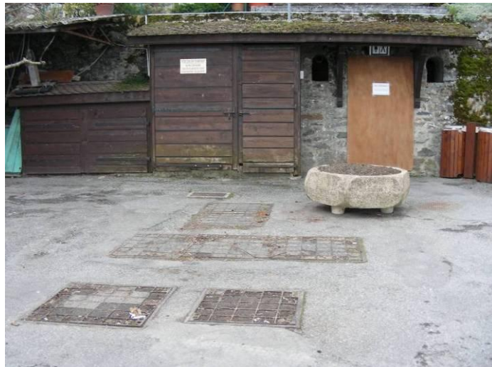
Figure 34 : Poste de refoulement, au droit du port d'Yvoire
