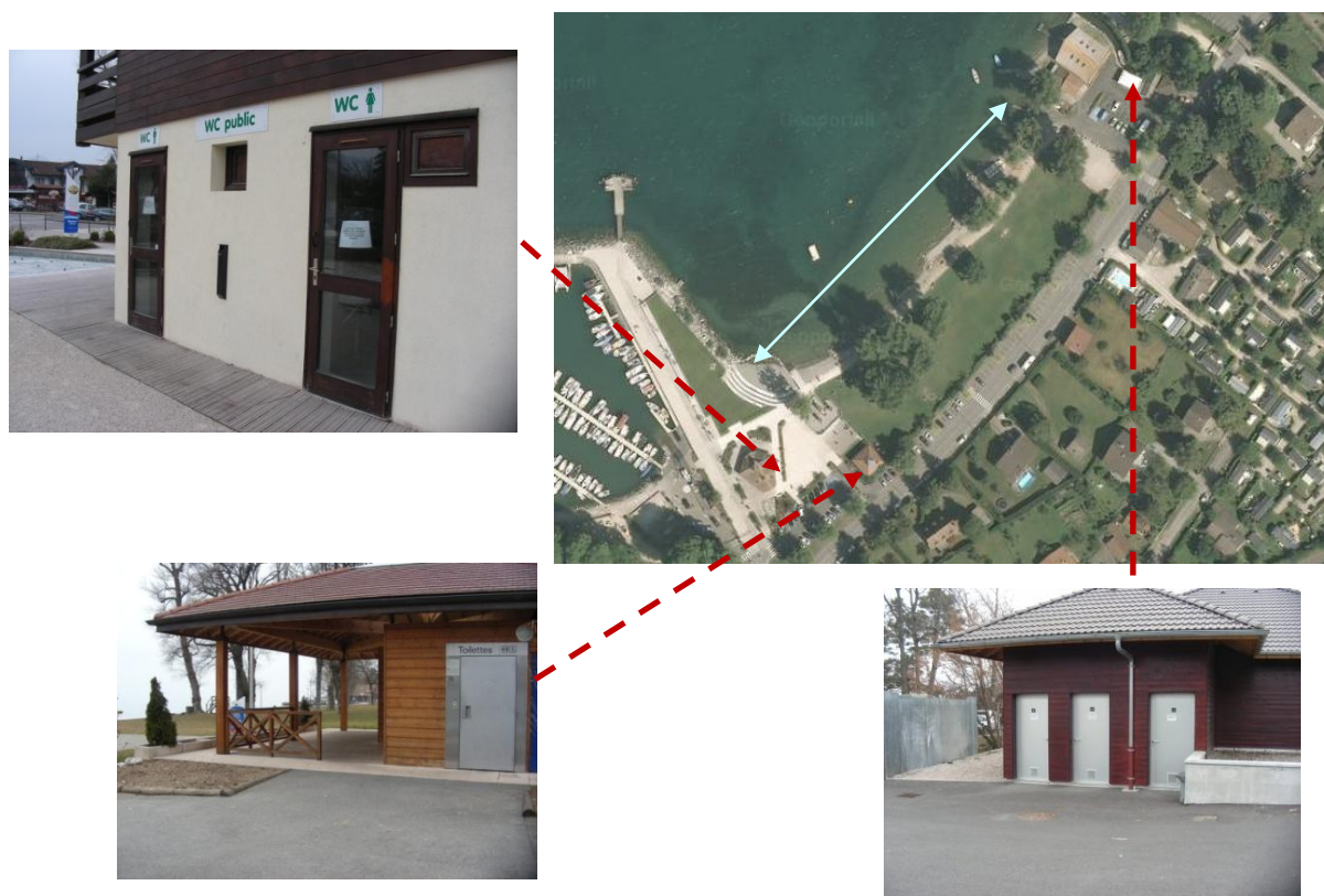
Figure 38 : Equipements sanitaires de la zone de baignade (Source : photo CIDEE)
