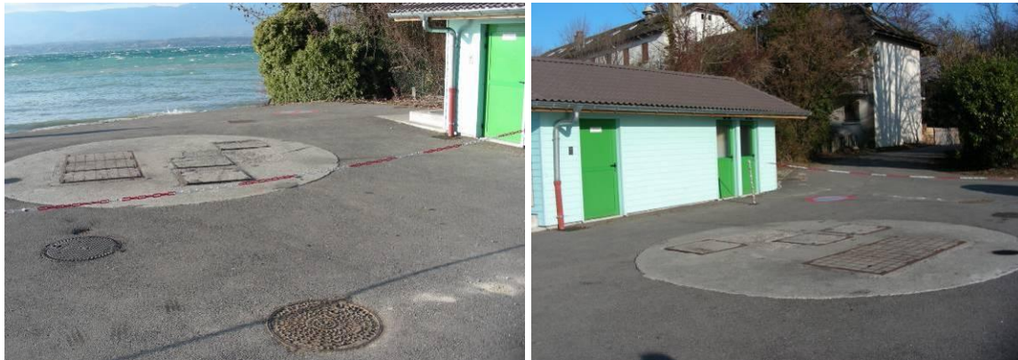
Figure 49 : Poste de refoulement de la zone de baignade de La Pointe (Source : photos CIDEE)
