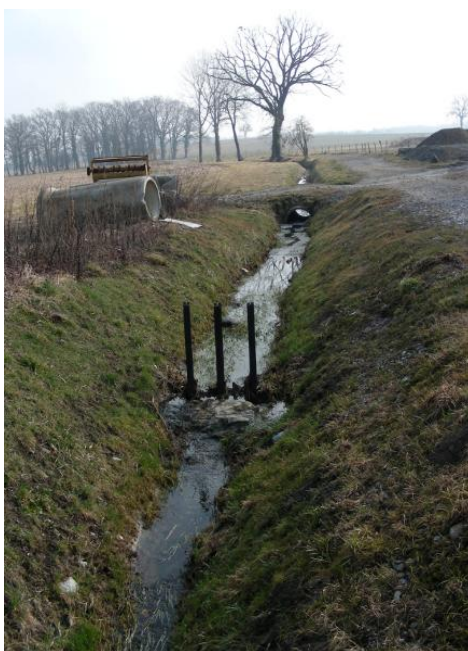
Figure 44 : Ruisseau des Dumonts (vue depuis l'aval, source: photo CIDEE)
