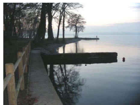
Figure 18 : digue du port à l'est et enrochement à l'ouest
