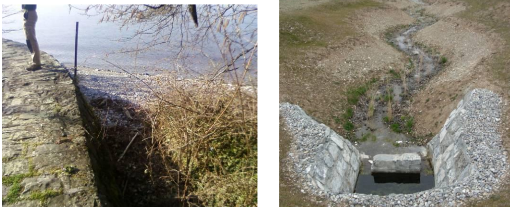
Figure 40 : Fossé de Saugey et noues situées à l'amont du fossé (Sources: photos CIDEE)
