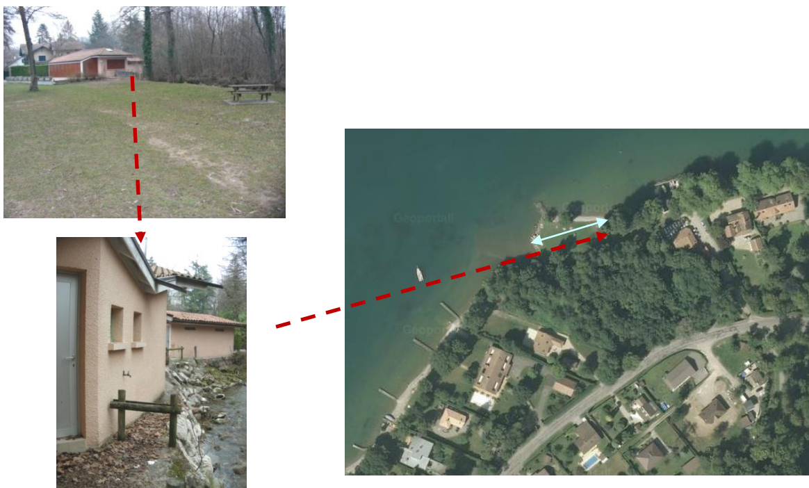
Figure 32 : Equipements sanitaires de la zone de baignade (Source : photo CIDEE)
