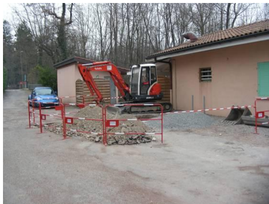
Figure 62 : Chemin d'accès à la zone de baignade et bâtiment accueillant un restaurant et les sanitaires (Source: photo CIDEE)
