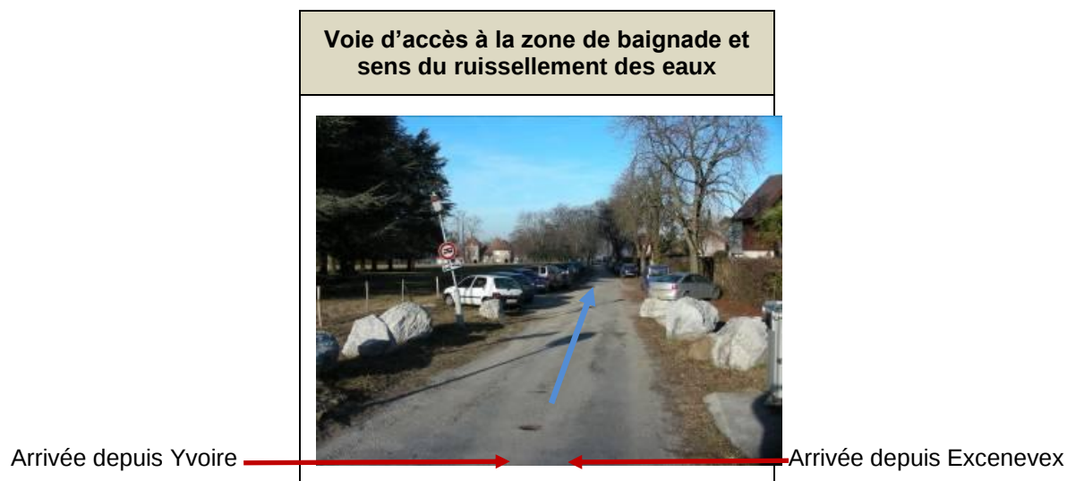
Figure 28 : Vues de la voie d'accès directe au site de Rovorée provenant de la route départementale D 25 : axe Yvoire : Excenevex
