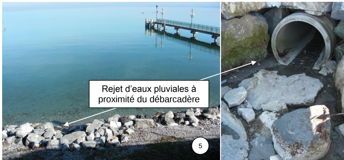
Figure 49 : Rejet d'eaux pluviales à proximité du débarcadère (Source : photos CIDEE)
