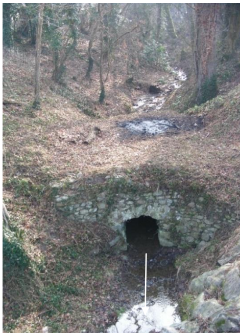
Figure 39 : Cours d'eau La Vorze - vue de l'aval au passage de la D25 (Source: CIDEE)
