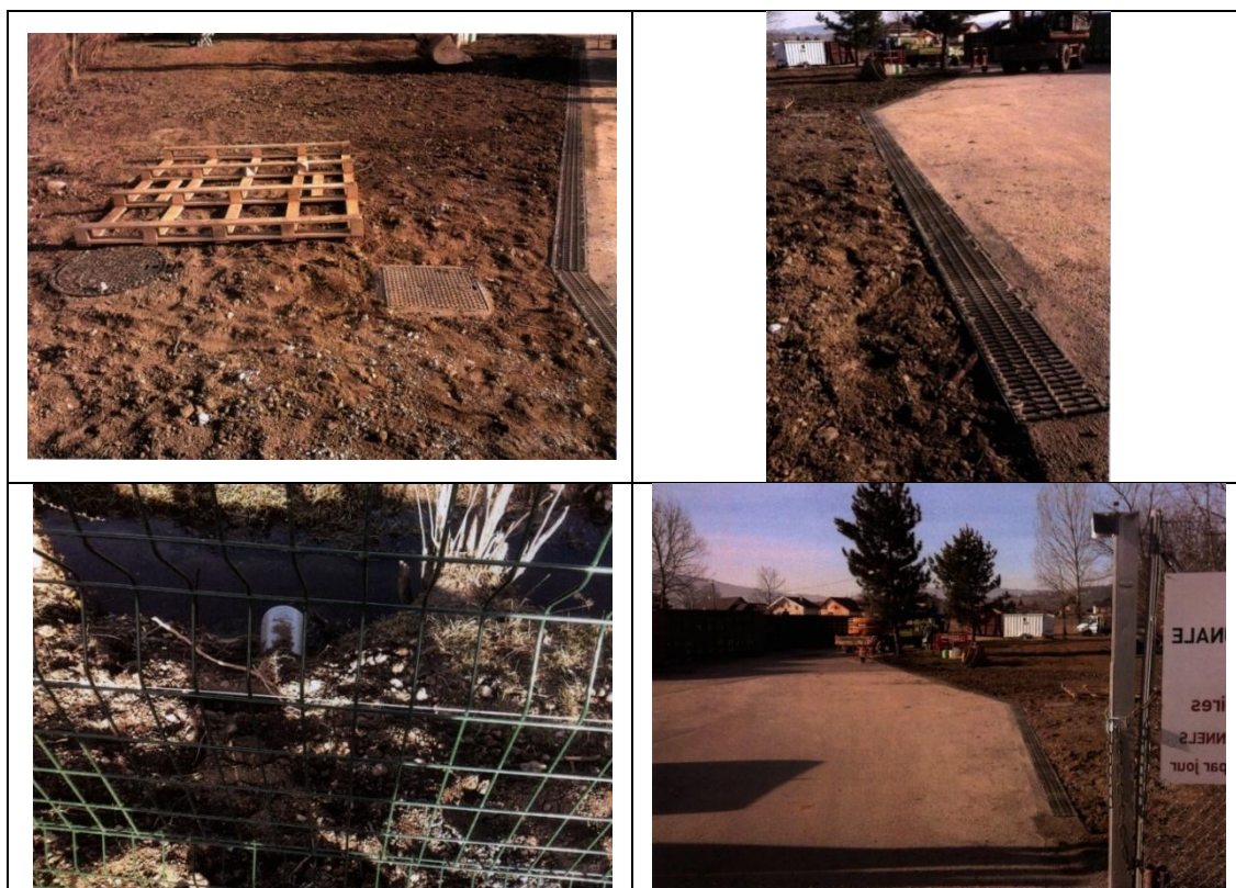
Figure 58 : Vues du site de la déchetterie intercommunale d'Artangy (Source: photos CCBC)
