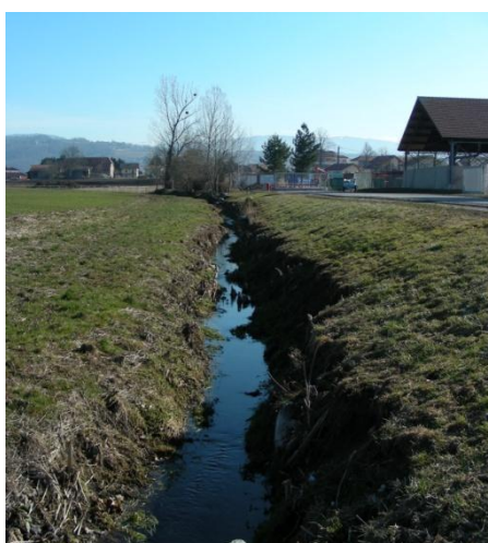
Figure 36 : Cours d'eau des Léchères au niveau de la STEP / déchetterie (Source: photo CIDEE)
