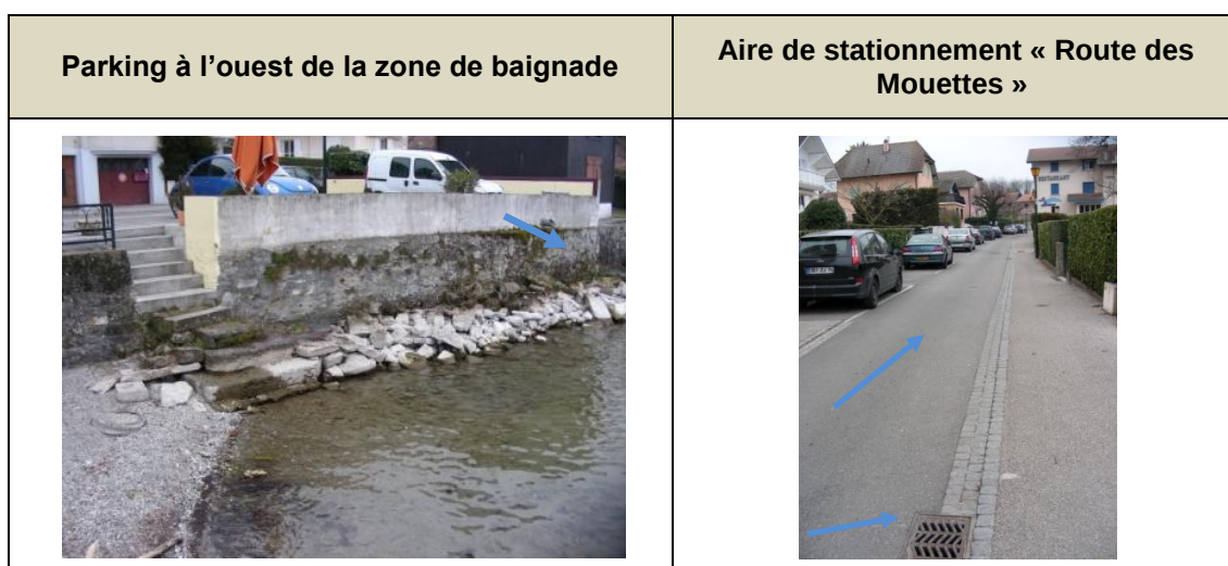
Figure 31 : Vues des parkings imperméabilisés et sens d'écoulement du ruissellement potentiel (Source : photos CIDEE)
