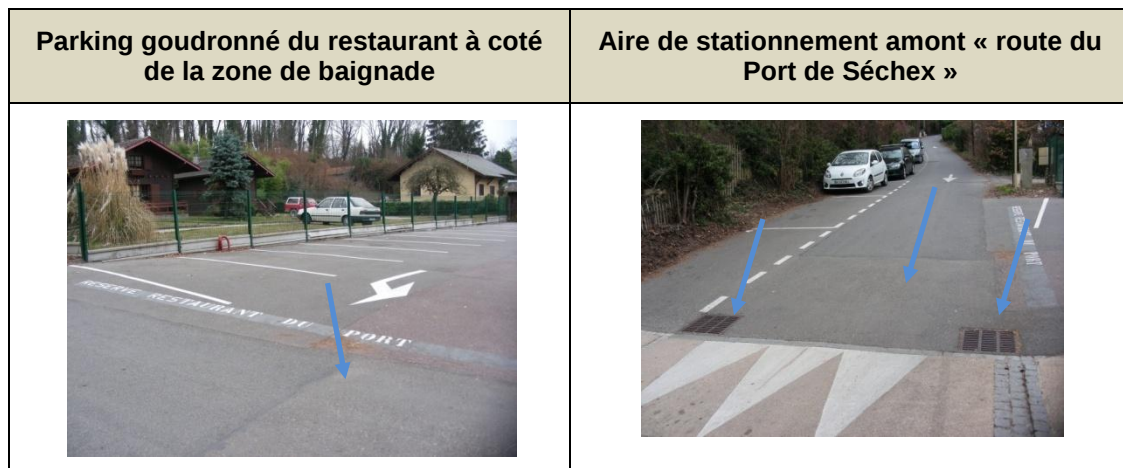
Figure 32 : Ruissellement des surfaces imperméabilisées de stationnement jouxtant la zone de baignade (Source : photos CIDEE)
