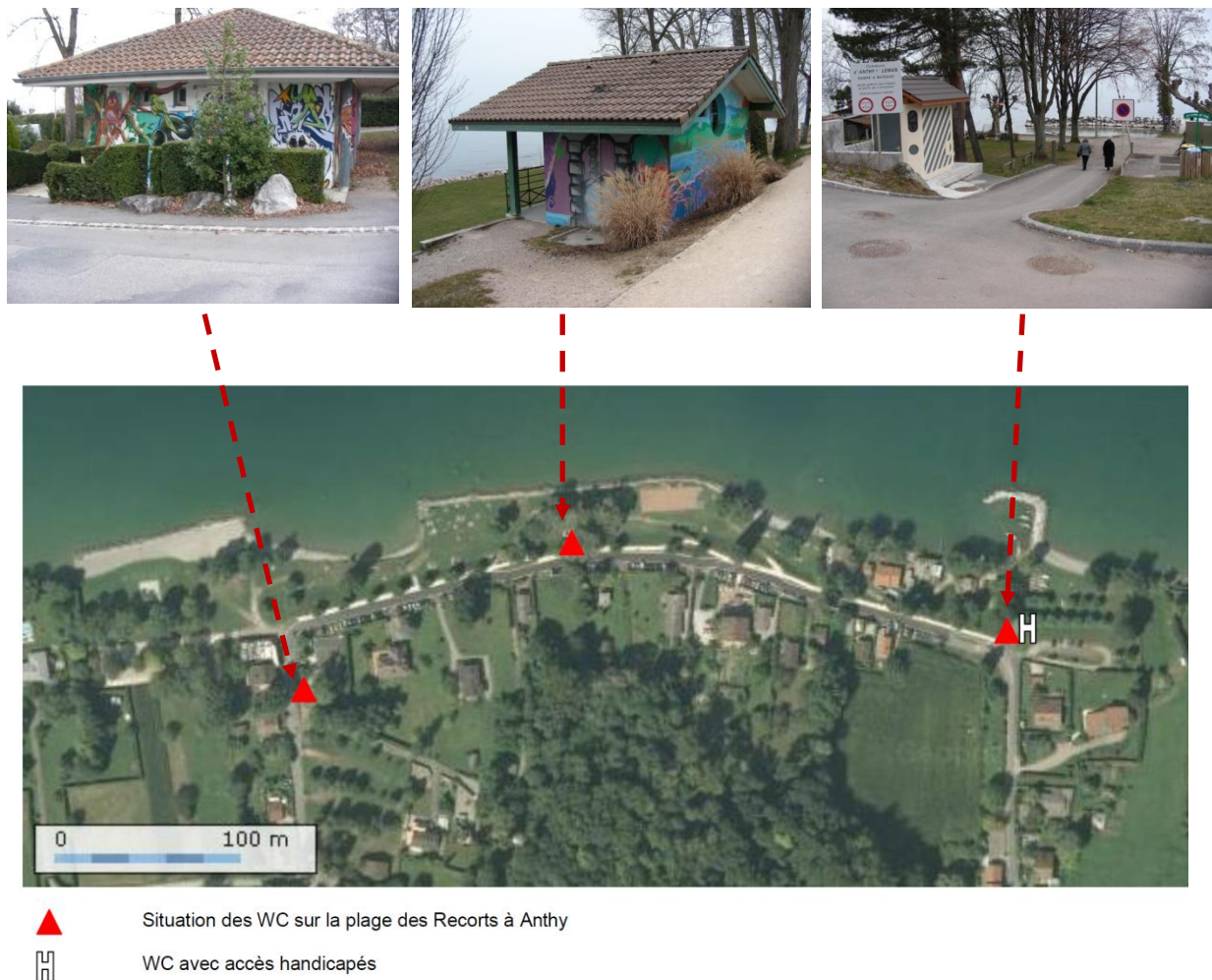
Figure 37 : Equipements sanitaires de la zone de baignade (Source : photo CIDEE)
