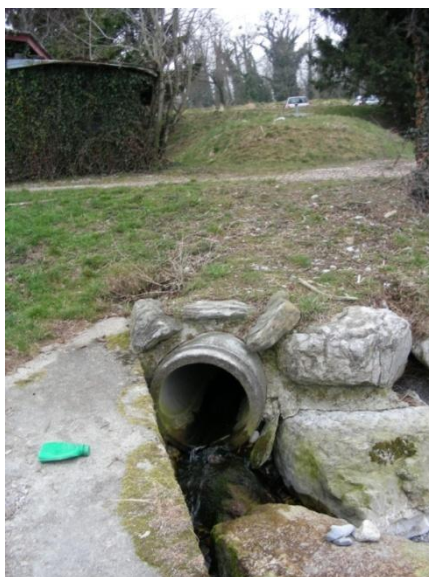
Figure 44 : Rejets d'eaux pluviales après traitement des hydrocarbures (Source: photo CIDEE)
