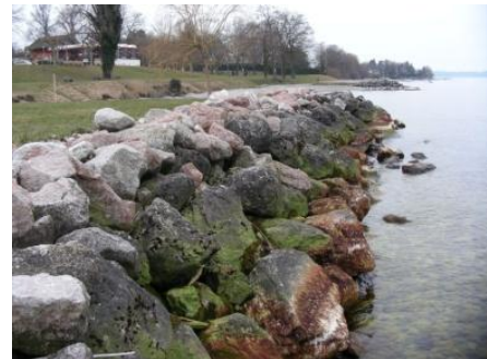
Figure 20 : enrochements de protection des berges
