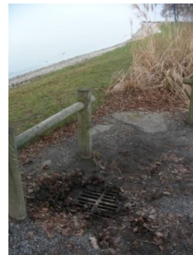
Figure 61 : Grille en bordure de la route (Source: photo CIDEE)
