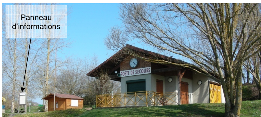
Figure 17 : Poste de secours (source : photo CIDEE)
