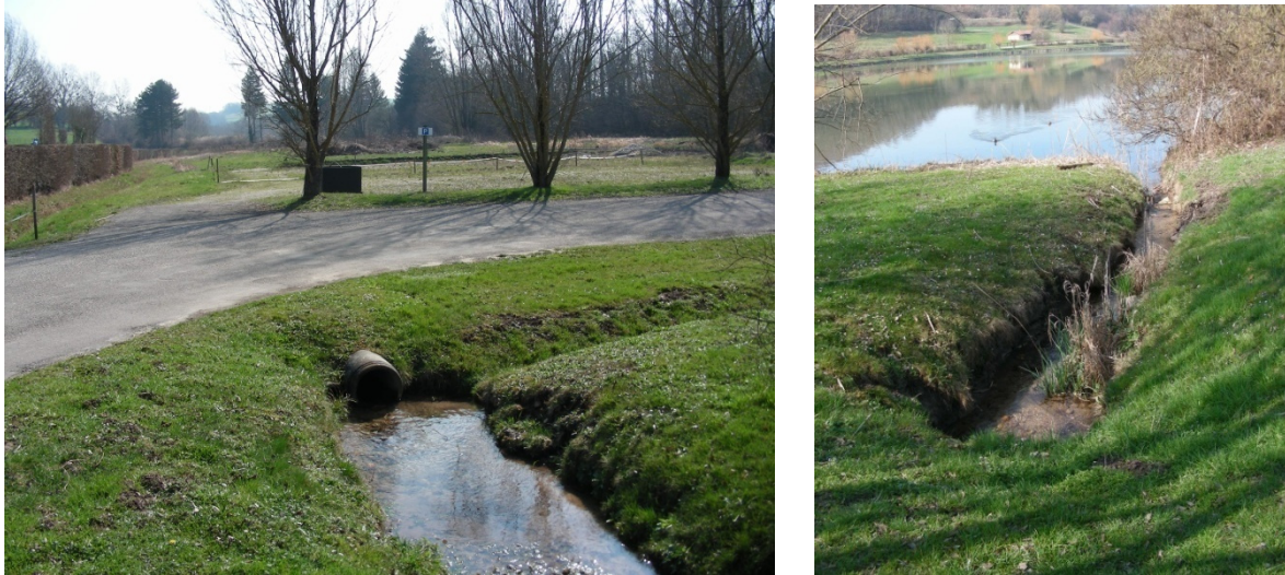
Figure 14 : Arrivée des eaux provenant des sources captées et de l'étang de Beau Soleil au niveau de l'étang du Moulin (source : photo CIDEE)
