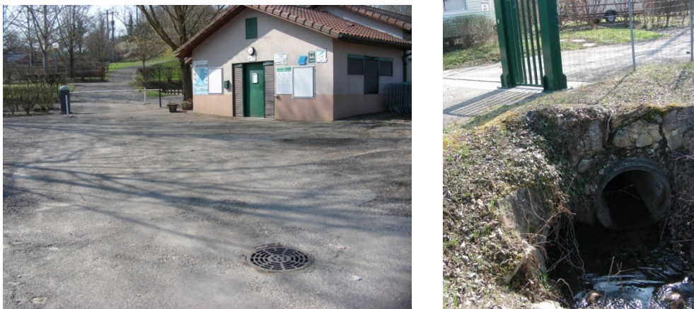
Figure 27 : Réseau d'eaux pluviales du camping (à gauche) et rejet dans la Gervonde (droite) (Sources: photos CIDEE)
