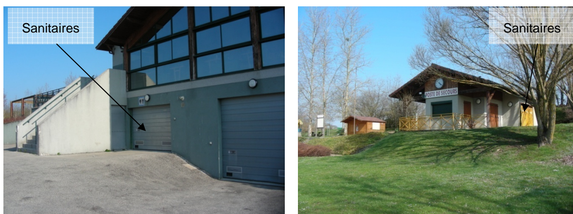
Figure 20 : Sanitaires au niveau du restaurant (à gauche) et du poste de secours (à droite) (source : Photo CIDEE)
