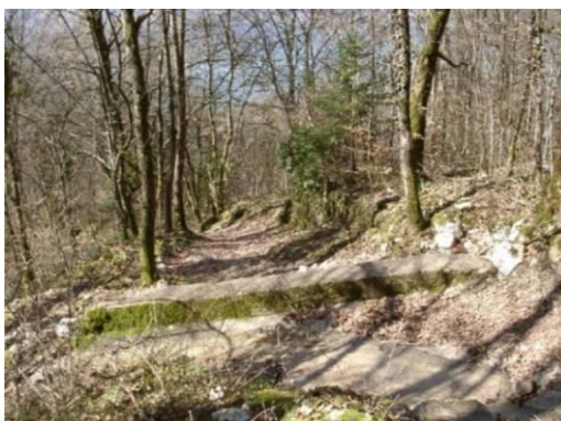
Figure 35 : Diguette en béton protégeant le quartier du Péril (Mars 2007, RTM)
