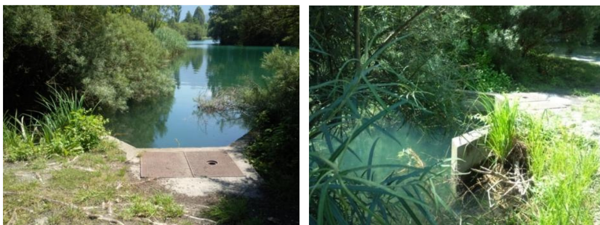
Figure 13 : Ouvrage d'évacuation du plan d'eau (source : photo CIDEE)
