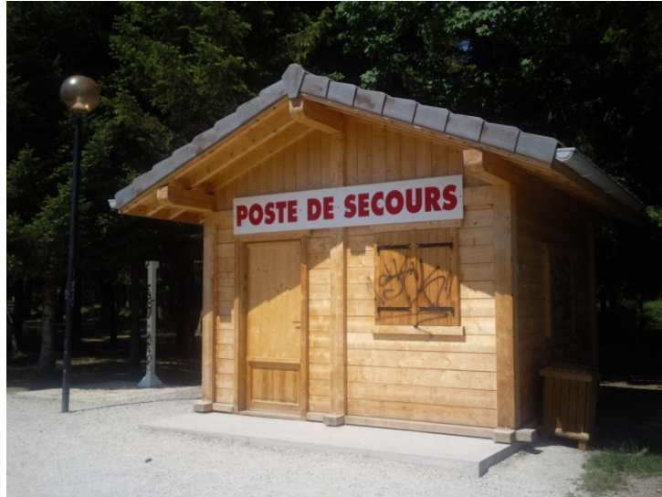
Figure 14 : Poste de secours (source : photo CIDEE)
