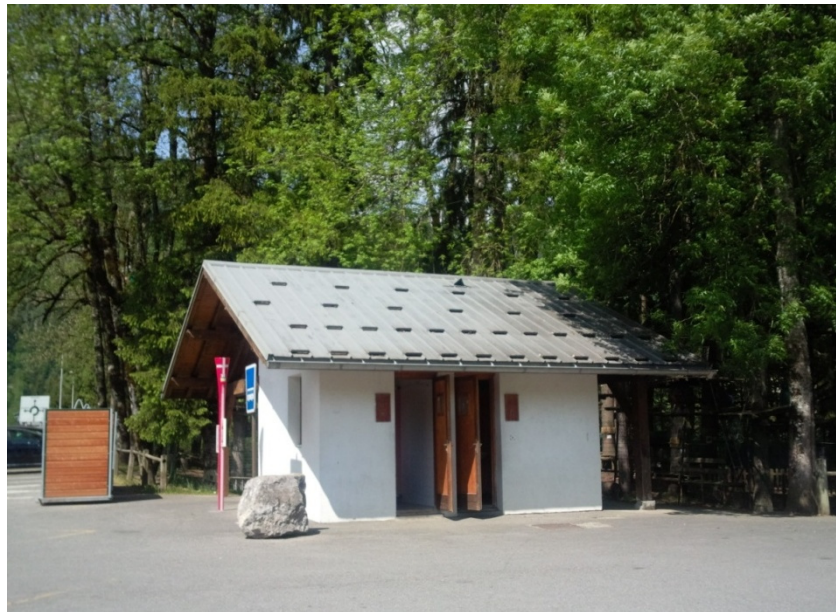
Figure 20 : équipements sanitaires (source : photo CIDEE)
