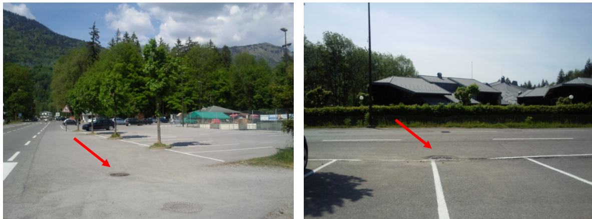
Figure 31 : Réseau d'eaux pluviales du parking (source : photos CIDEE)
