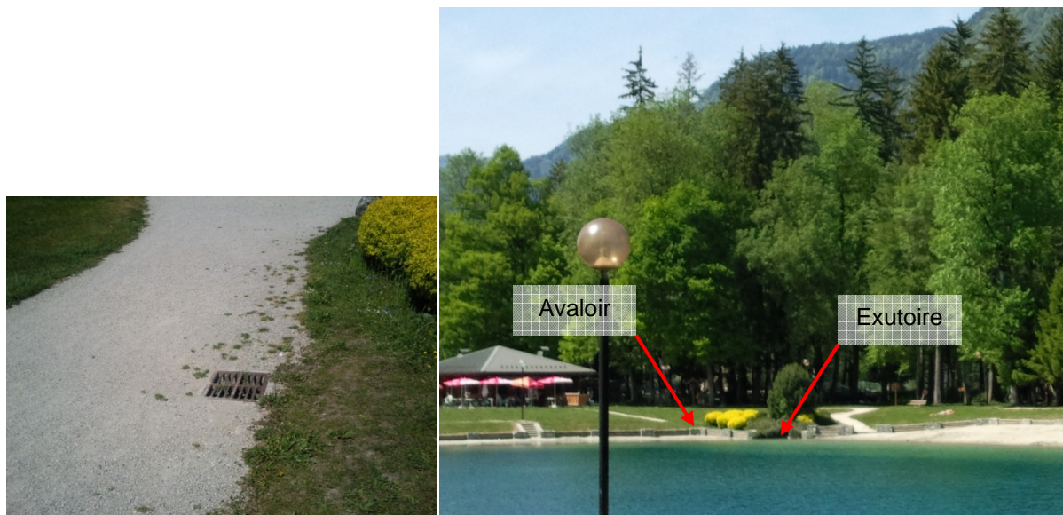
Figure 32 : Avaloir connecté à l'exutoire du lac bleu (source : photos CIDEE)
