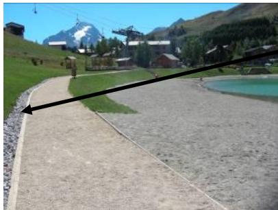
Localisation du drain de récupération des eaux de ruissellement du versant amont
