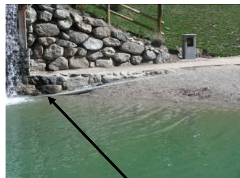
Localisation de l'exutoire du drain sous la cascade
