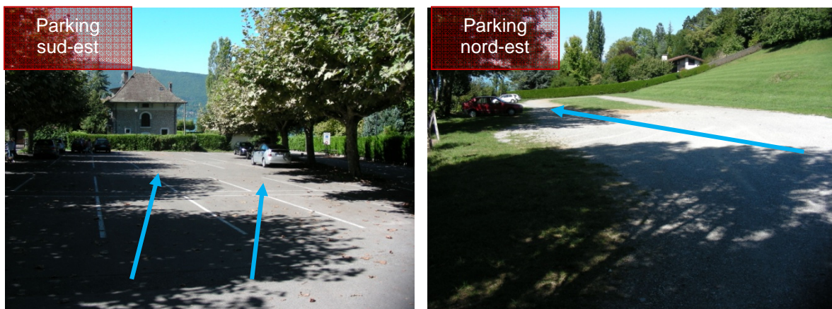
Figure 30 : Parkings sud-est et nord-est et sens d'écoulement des eaux de ruissellements (source : photo CIDEE)
