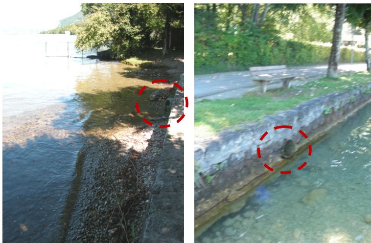
Figure 41 : Rejet d'eaux pluviales en limite de la zone de baignade (à gauche) et rejet un peu plus éloigné du côté sud de la plage (à droite) (Source: photo CIDEE)
