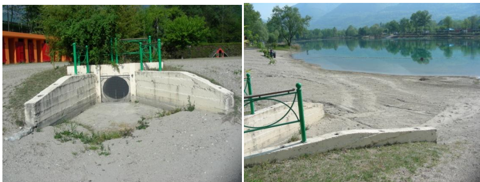
Figure 19 : Déversoir régulant le niveau du lac (source : photo CIDEE)
