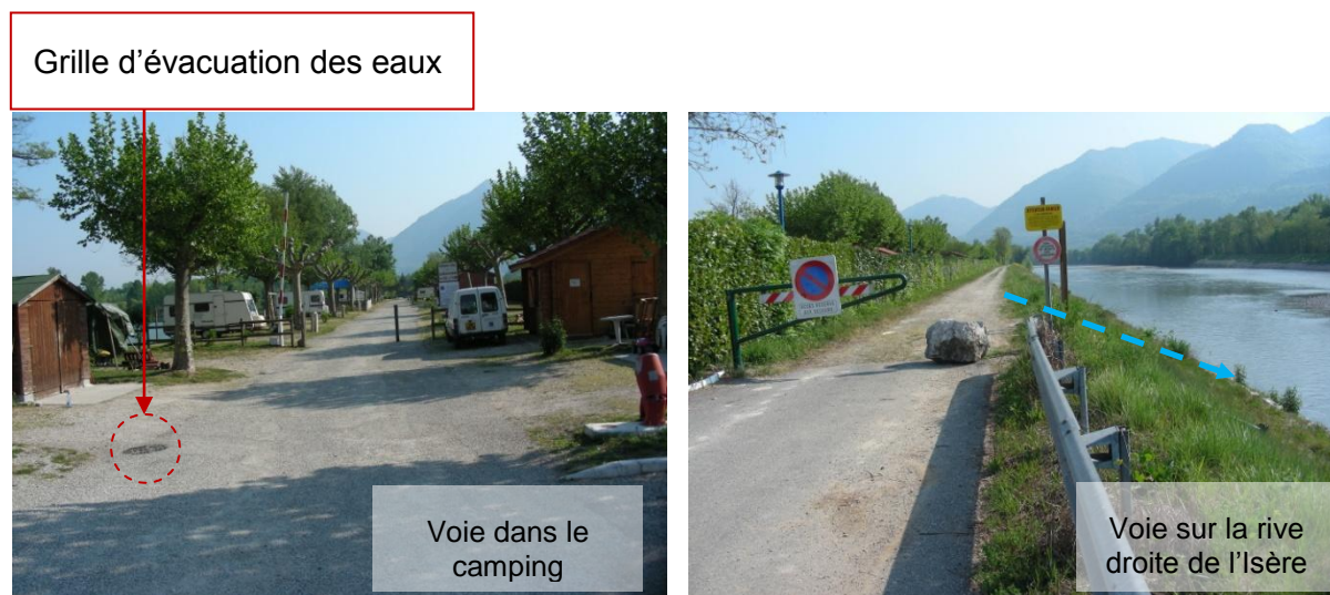
Figure 45 : Ruissellements sur les voies rive Est du site (source : photo CIDEE)
