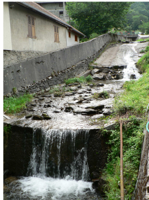
Artificialisation du lit et des berges (ruisseau des Moulins)
