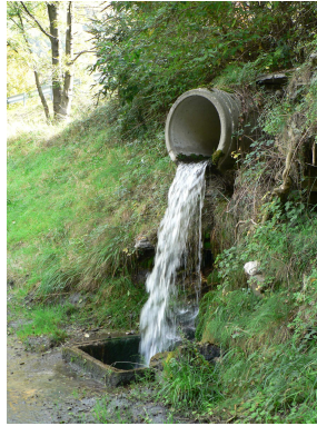
Confluence busée et perchée au dessus de l'Isère (ruisseau de Feissons sur Isère)
