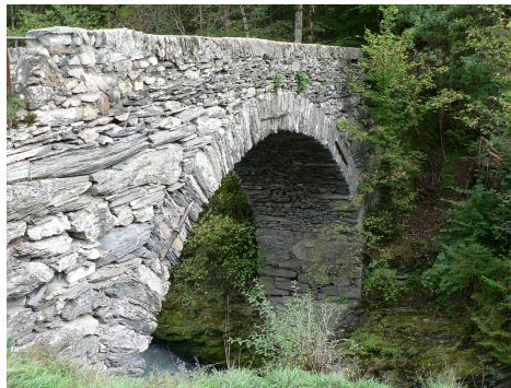
Pont voûté en pierres sèches au-dessus de l'Isère
