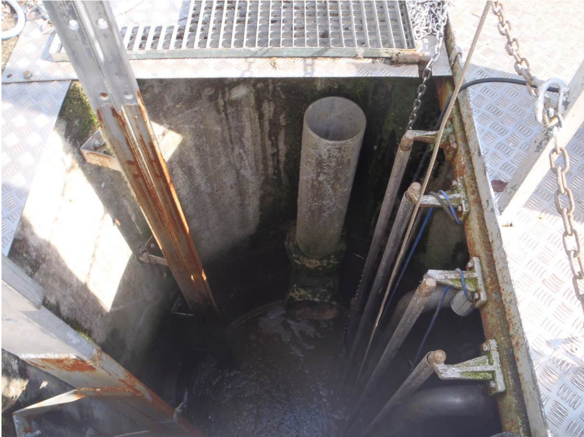
Photo n° 5 : Aperçu intérieur du déversoir d'orage
