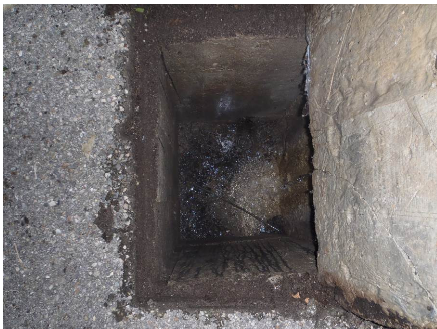
Photo n° 6 : Trop plein du bassin communal
