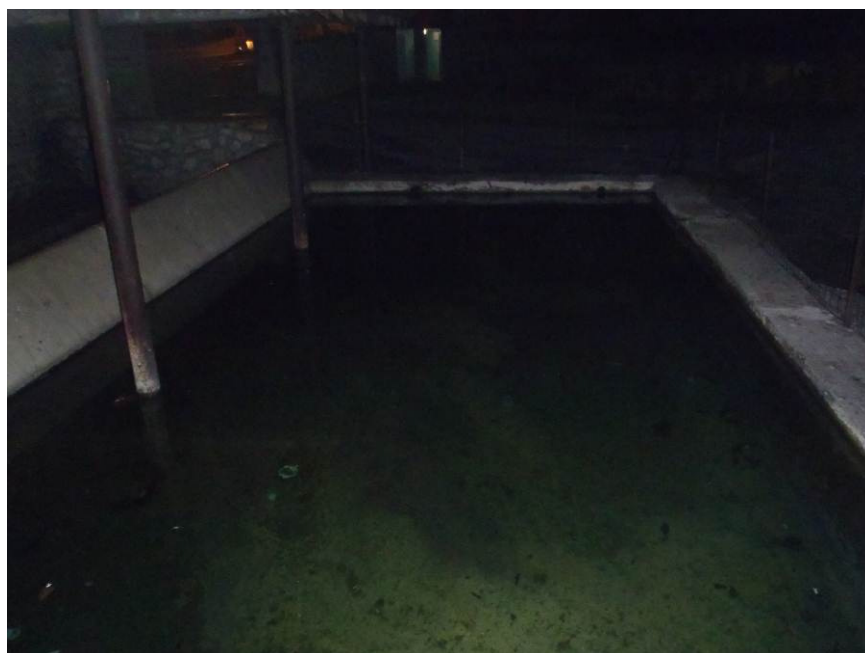
Photo n° 7 : Aperçu du bassin
