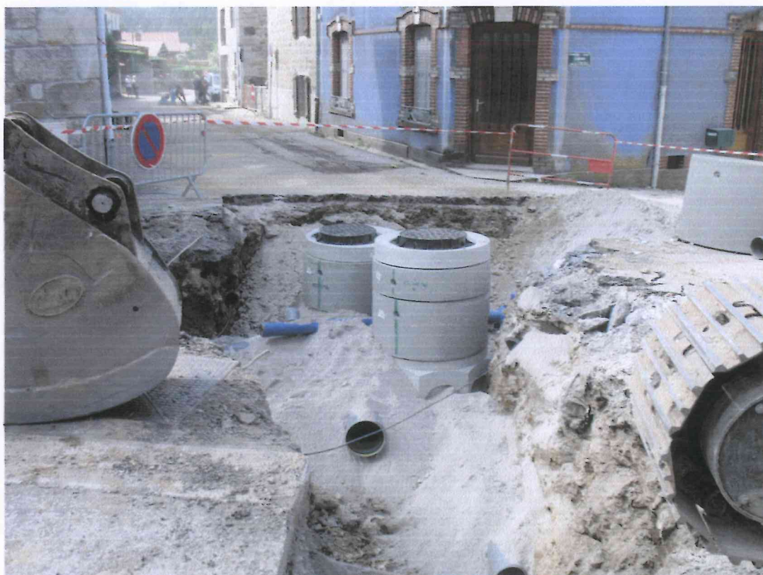
Travaux rue de la Creuse
