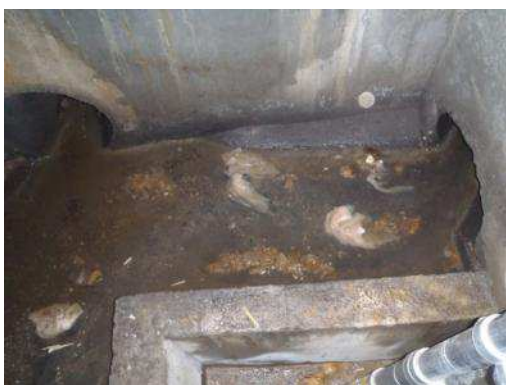
Déversoir n°15 (Rond-point RD8) – Type latéral simple
