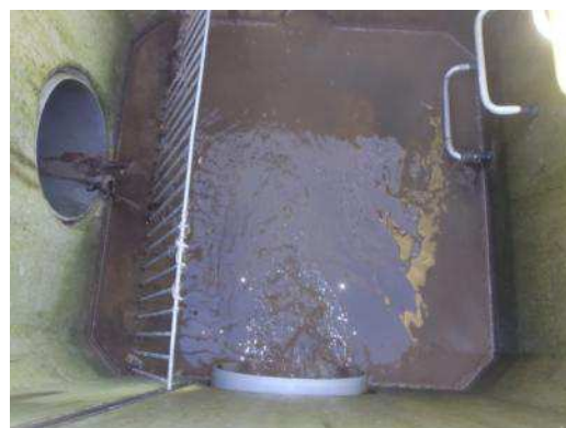
Déversoir n°80 (Station d'épuration) – Type Trop-plein avec dégrillage (entrefers 40 mm)
