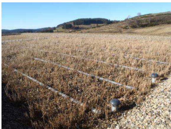
2 e étage de filtres plantés de roseaux
