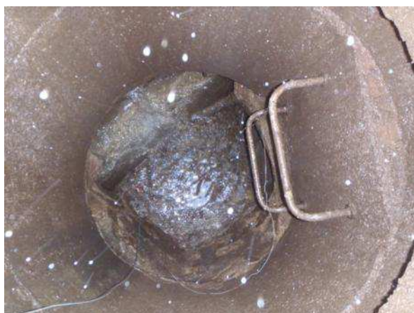
Regard n° 9 (Chemin de la Travarie) – Eaux claires parasites permanentes
