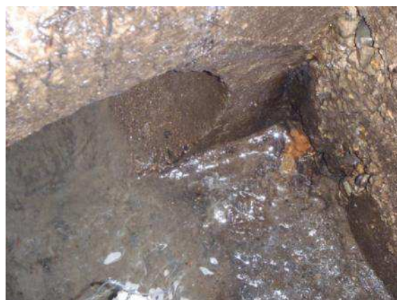
Regard n° 32 (Chemin de la Travarie) – Infiltration au niveau du radier
