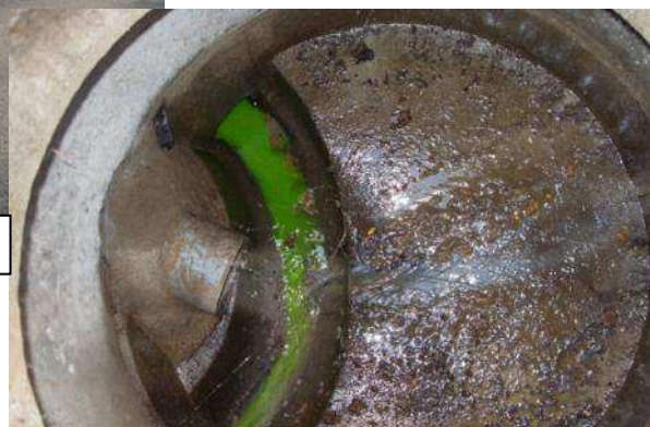
3 - validation de la connexion hydraulique à l'aide de colorant
