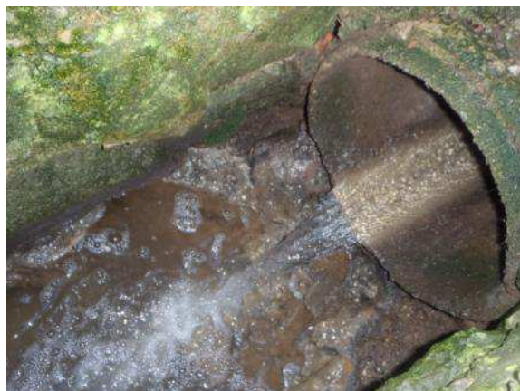
Chemin de la Creuse – Défauts de génie civil et eaux claires parasites permanentes
