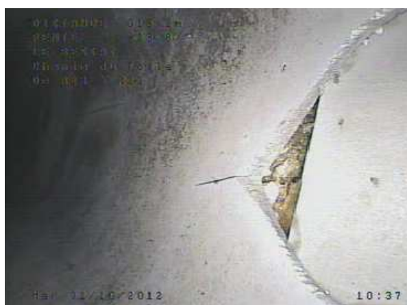
Paroi manquante Chemin du Thoile : 22 à 23
