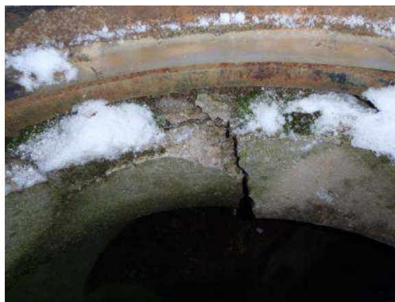
Regard n° 32 (Chemin de la Travarie) – Infiltration au niveau du radier
