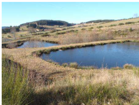
2 bassins de lagunage de finition et de traitement du temps de pluie
