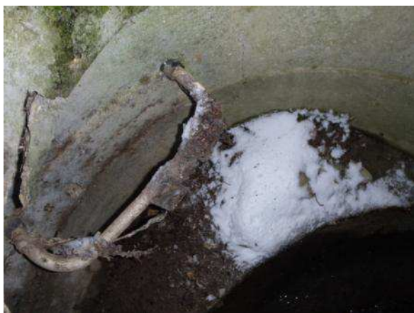
Regard n° 2 (Chemin de la Croix Blanche) – Traces de mises en charge
