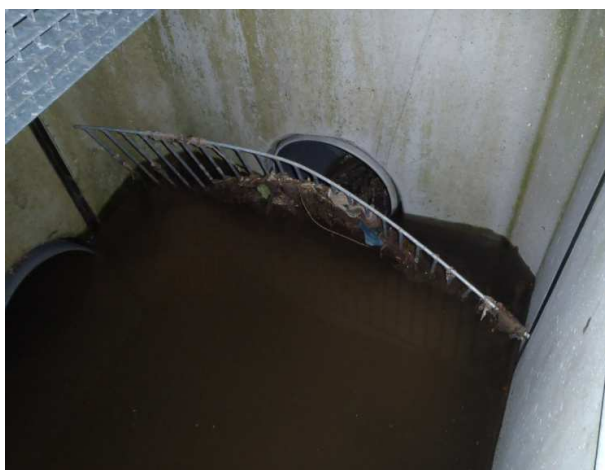
Mise en charge de l'ouvrage en entrée de station
