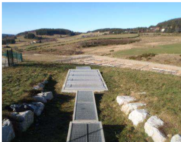
Vue extérieure dégrilleur, déversoirs, ouvrage de bâchées
