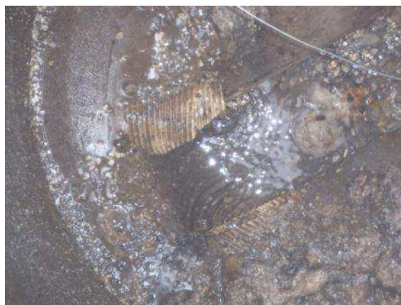
Regard n° 22 (Chemin du Thoil) – Drains et dépôts
