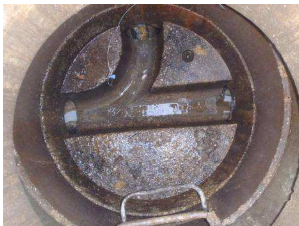
Regard n° 43 (Chemin du Tremplin) – Infiltration au niveau de la cheminée
