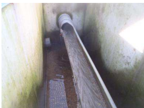
Déversoir n°15 (Rond-point RD8) – Type latéral simple
