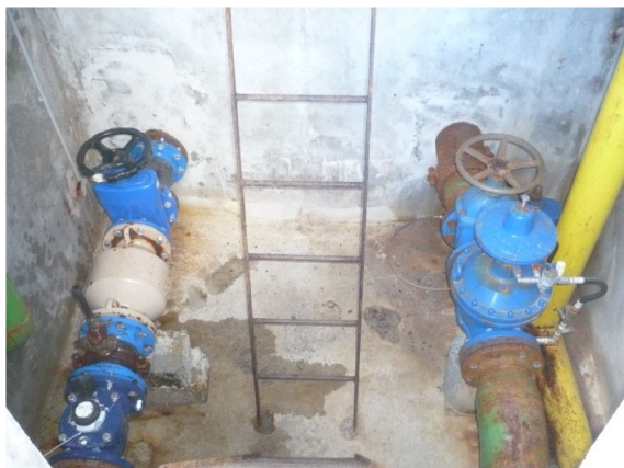
Réservoir de Brison : Chambre de vannes ;
