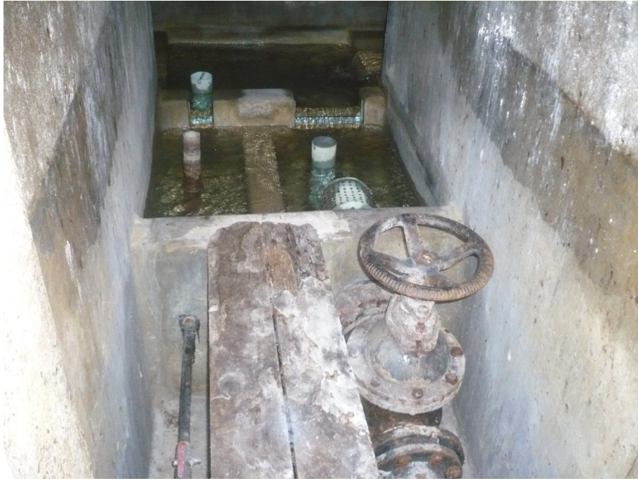
Aperçu de la chambre de réunion et de tranquillisation
