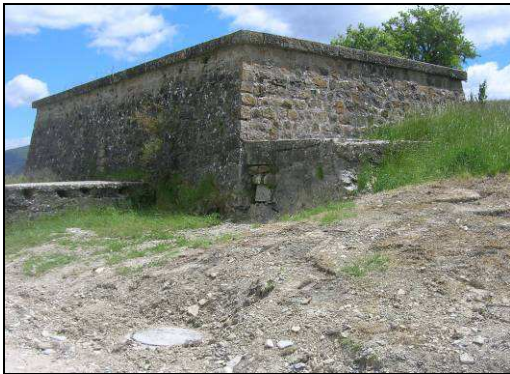
Photo 13 : Extérieur du réservoir du Village
