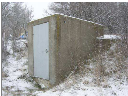
Photo 11 : Extérieur du réservoir de Font Arlaude
