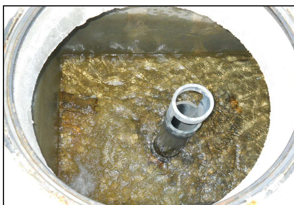
Intérieur du regard de captage
