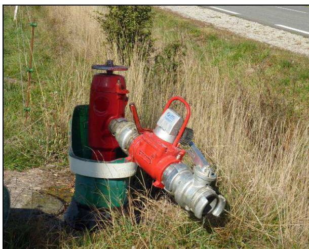
Photo 17 : Campagne de tests des poteaux incendie (Source : HYDRETTUES – le 6 oct. 2010)
