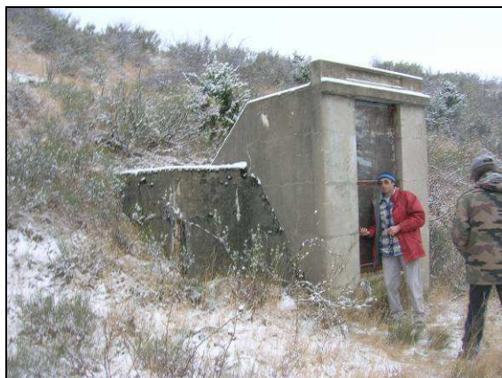
Photo 9 : Extérieur du réservoir du savel
