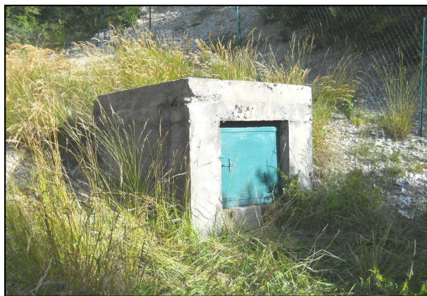
Aspect extérieur de l'ouvrage de captage
