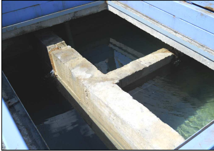
Intérieur de l'ouvrage
