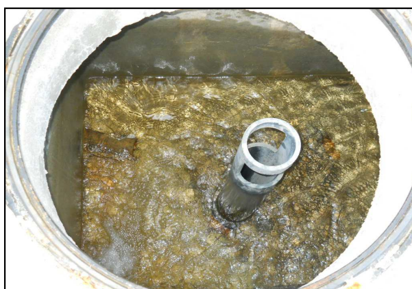
Intérieur du regard de captage
