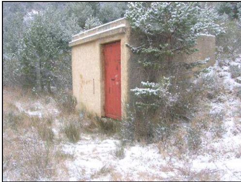
Photo 7 : Extérieur du réservoir des Struis
