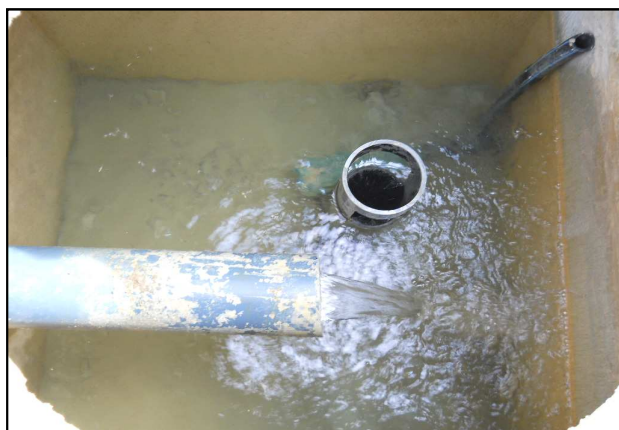
Intérieur du regard de captage
