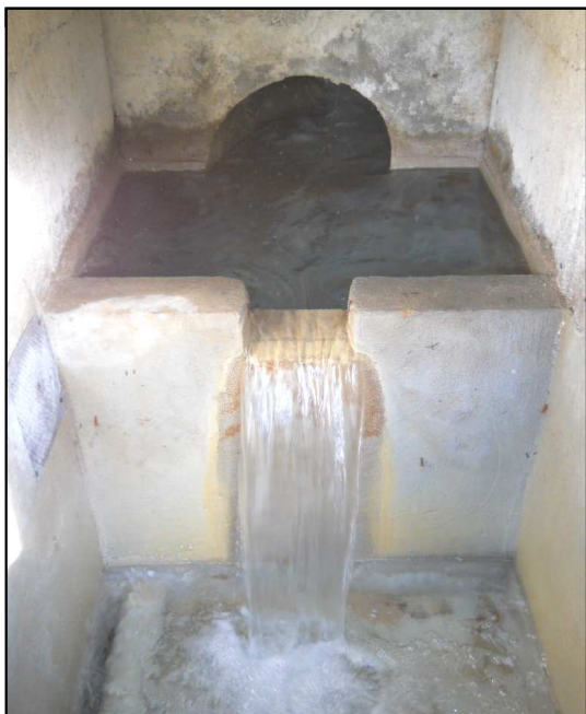
Intérieur de l'ouvrage de captage
