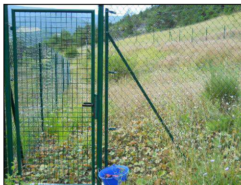
Photo 6 : Zone de captation grillagée
