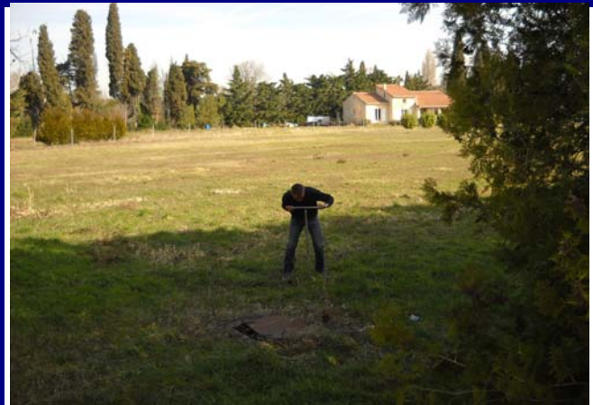
Vue du sondage
