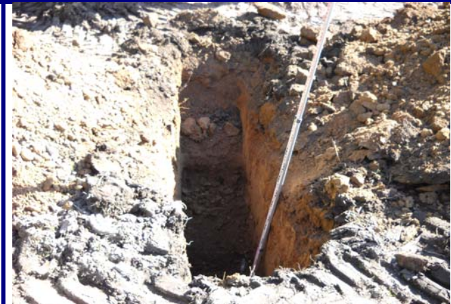
Vue du sondage
