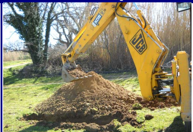
Vue du sondage
