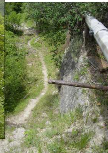
(3) Descente par l'escalier
