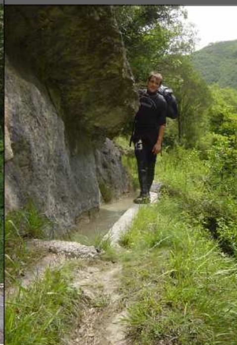
(2) Passage sous le dévers
