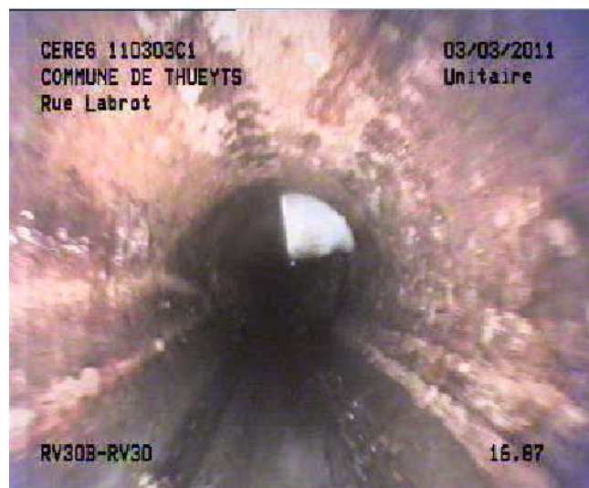
Raccordement pénétrant Rue Labrot
